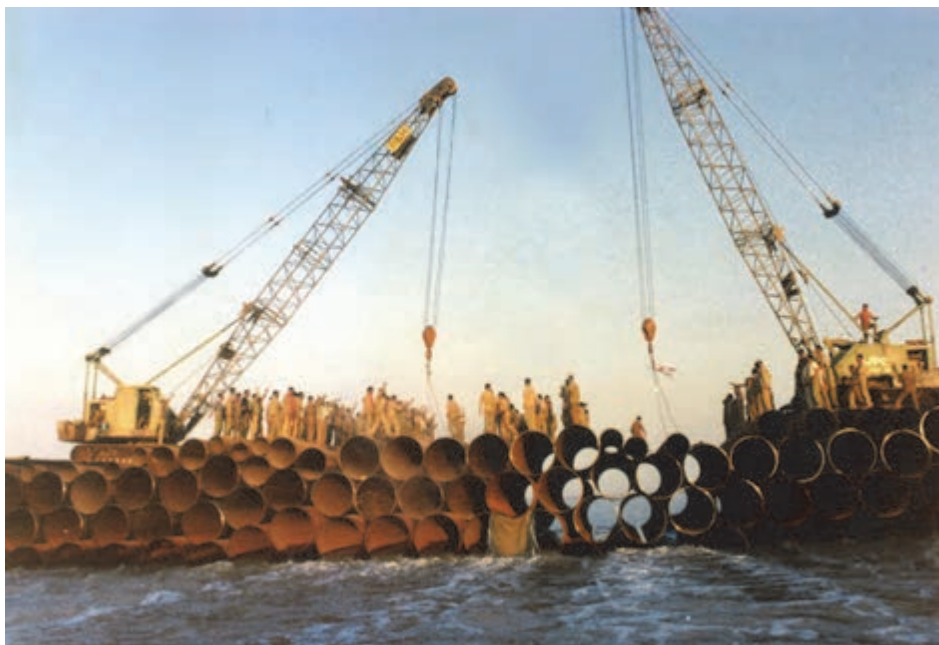
شکل ۱۱-۵- پل بعثت در حال ساخت
