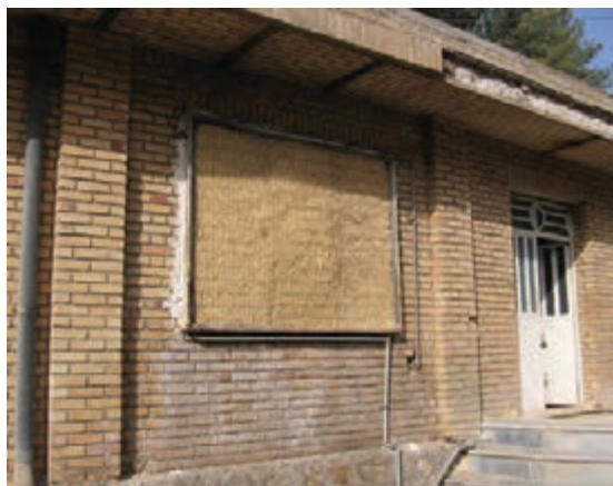
تصویر ۱۳-۲ انواع سیستم پوشال و هواکش
