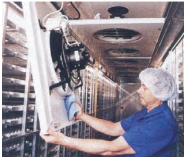
تصویر ۲۱-۴- سرویس دستگاه‌های تهویه
