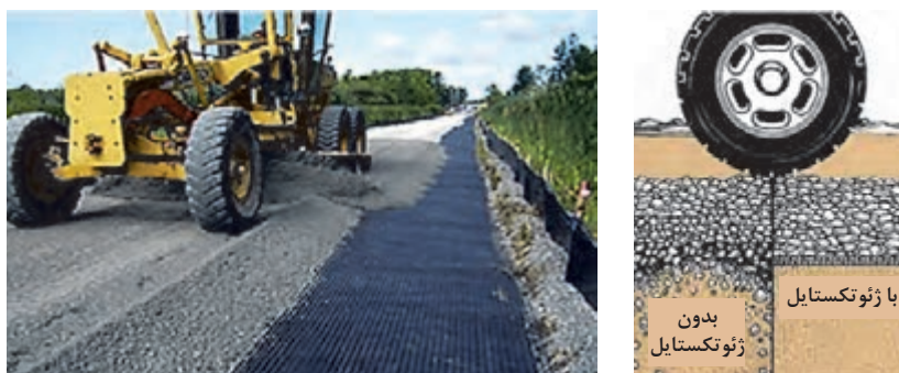
شکل ۲۵- کاربرد پارچه های ژئوتکستایل در زیرسازی راه
