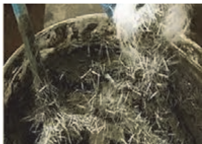
شکل ۱۸- استفاده از الیاف شیشه در مخلوط سیمان
