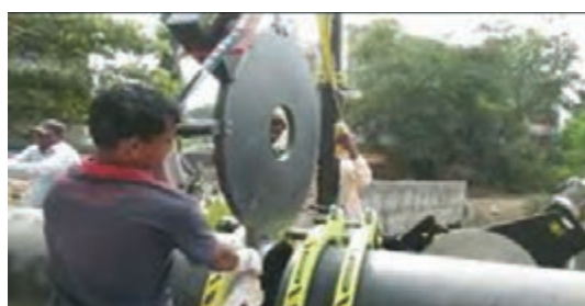
شکل ۱۸- جوشکاری لب به لب Butt Fusion
