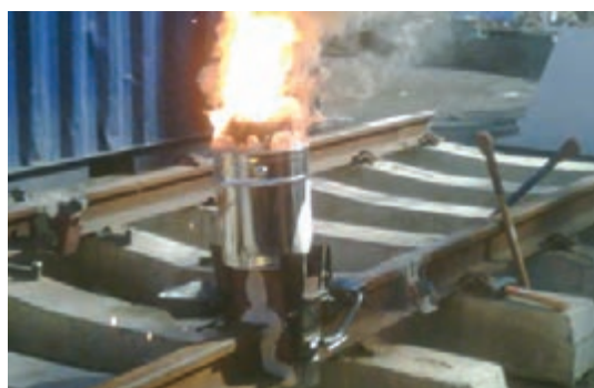
شکل ۲۱- نمایی از انجام واکنش ترمیت
