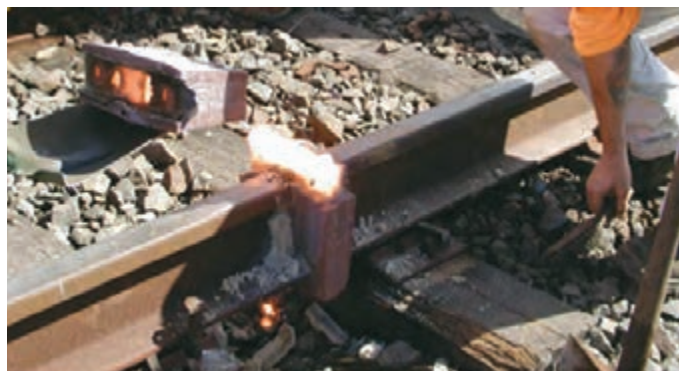
شکل ۲۳- شکستن قسمت فوقانی قالب
