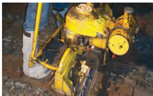
شکل ۲۵- سنگ زنی و پرداخت کاری سطح گرده
