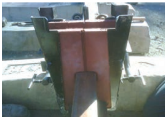
شکل ۱۸- نصب قالب اطراف ناحیه اتصال
