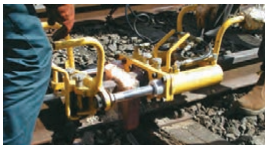
شکل ۲۴- برش گرده اضافی جوش
