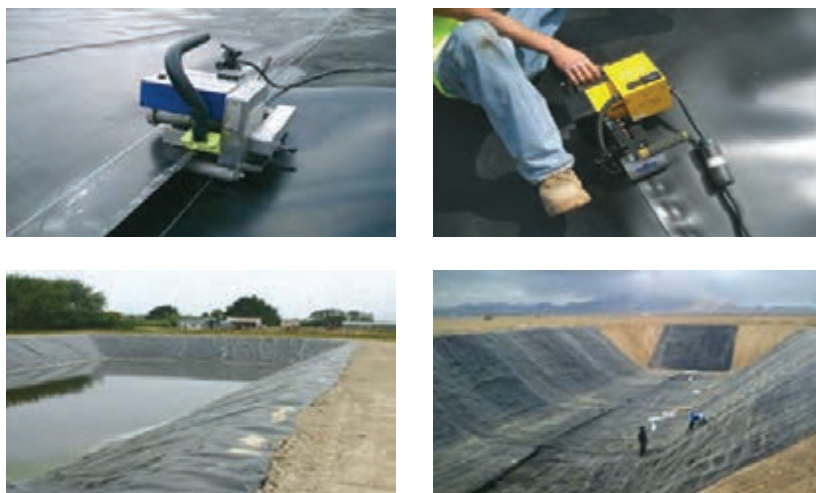
شکل ۱۴- جوشکاری عایق‌های پلاستیکی (ژئوممبران) استخرهای ذخیره آب
