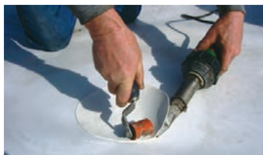
شکل ۱۱- جوشکاری با گاز داغ به صورت دستی
