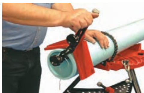
شکل ۲۴- پخ زدن قطعات پلاستیکی برای جوشکاری
