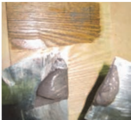
شکل ۱۳۸- برداشتن بتونه
