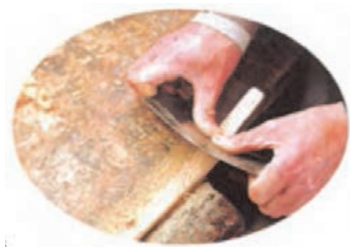
شکل ۵۶- استفاده صحیح از لیسه
