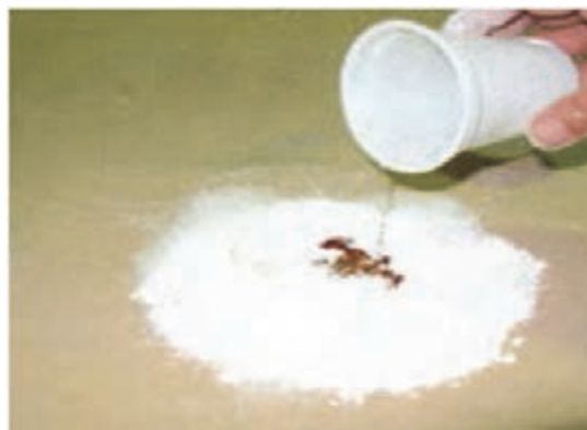
شکل ۷۸- اضافه نمودن آب به بتونه روغنی
