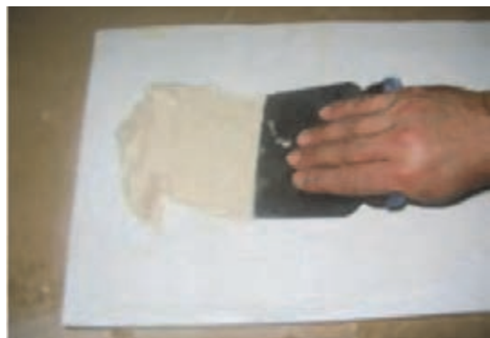
شکل ۹۱- ساخت بتونه سریشی
