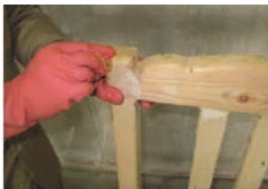
شکل ۷۱- بتونه کاری غیر پوششی
