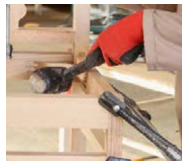
شکل ۱۰۷- جا زدن نبشی به وسیله چکش پلاستیکی
