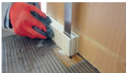
شکل ۹۰- عملیات برش زبانه با دستگاه اره نواری
