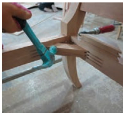
شکل ۵۸- جا زدن نبشی‌های گوشه
