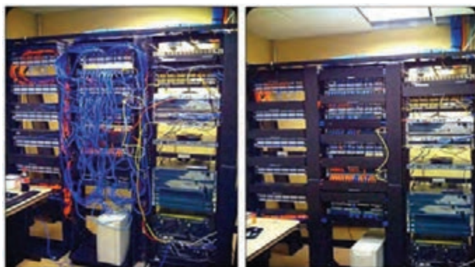
شکل ۴۱- مرتب کردن کابل‌ها
