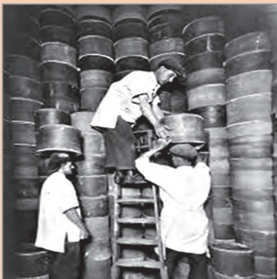
شکل ۶۷ - چیدمان ستونی ساگارها در کوره‌های سنتی
