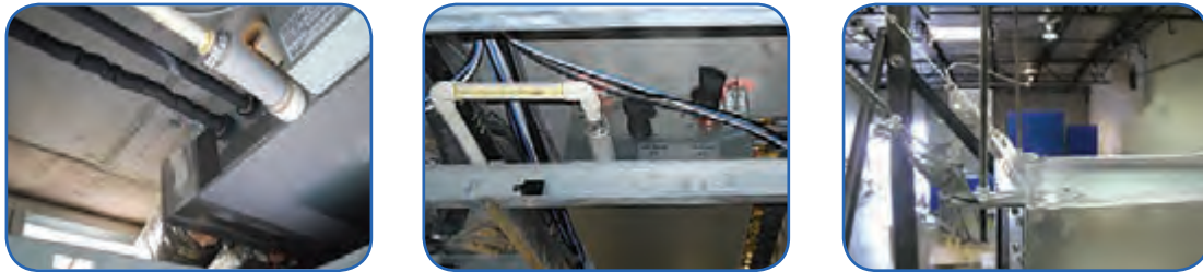
شکل ۸- نمونه اتصال لوله تخلیه به تشتک
