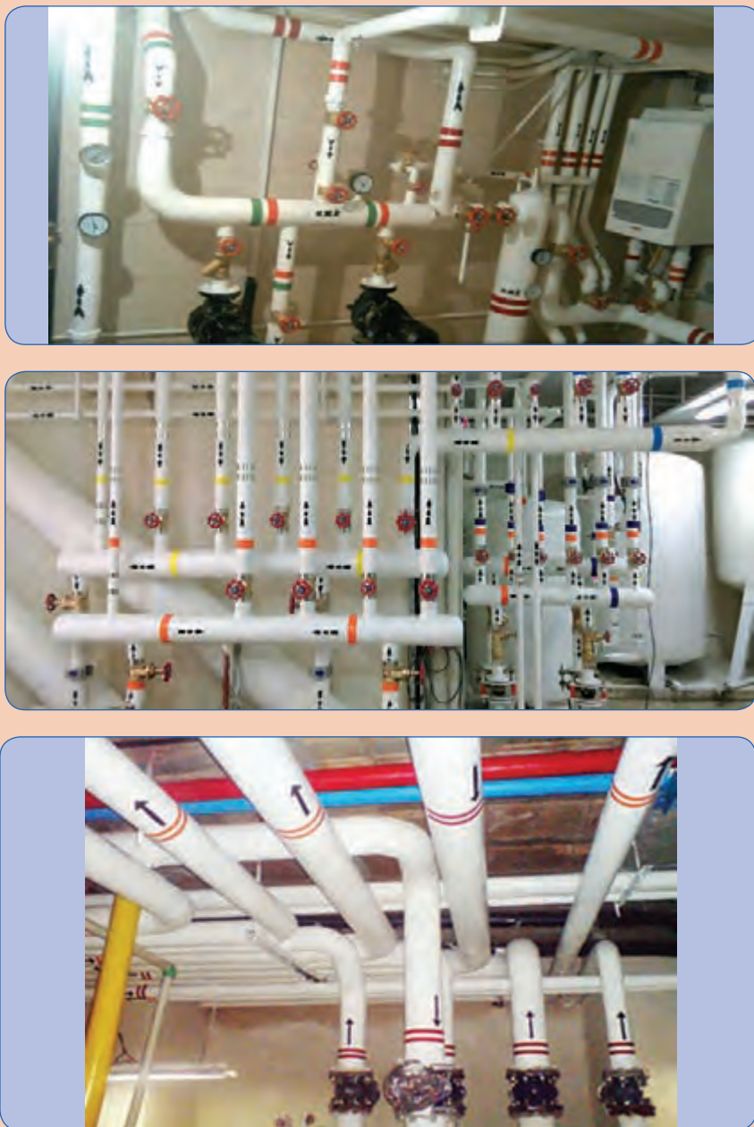
شکل ۱۴ - موتورخانه با رنگ آمیزی نهایی و فلش و نوار رنگی
