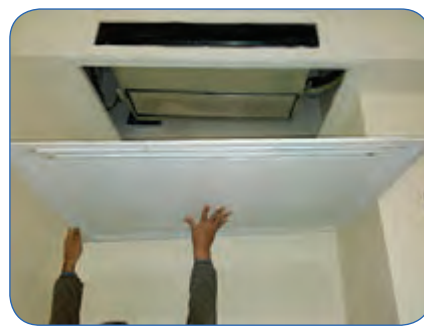
شکل ۱۴. نمونه دریچه دسترسی و برگشت هوا
