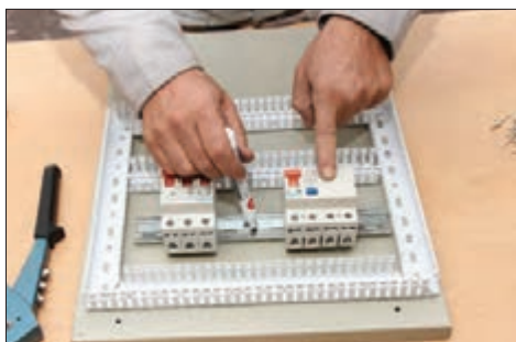
شکل ۴۲- محل نصب ریل فلزی
