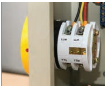
الف) نمای پشتی پریزهای نصب شده روی در تابلو و نمای پشتی پریز سه فاز
