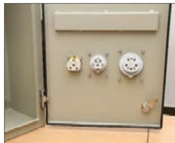
الف) نمای پشتی پریزهای نصب شده روی در تابلو و نمای پشتی پریز سه فاز
