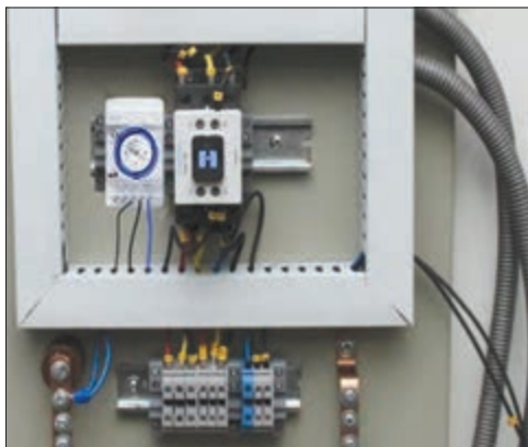
شکل ۱۰۷- محل نصب تایمر ۲۴ ساعت در تابلو روشنایی
