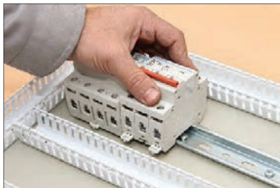
شکل ۴۶- نصب قطعات روی ریل
