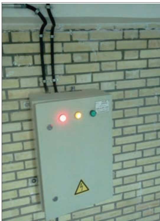
شکل ۲۰- مسیر ورود و خروج کابل‌ها در تابلو
