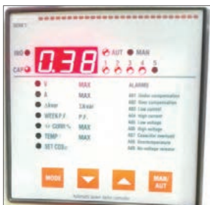
شکل ۲۲- نتیجه عملکرد رگولاتور اصلاح ضریب توان
