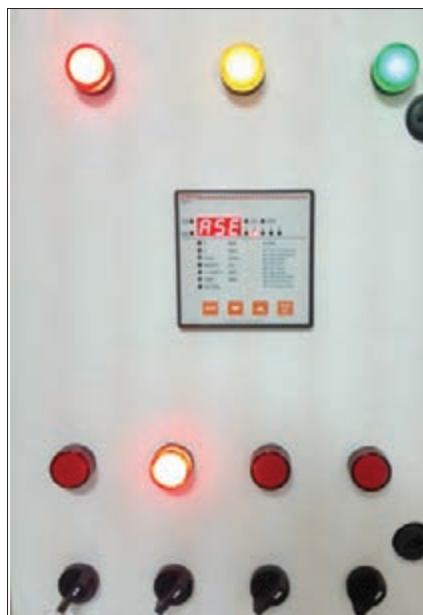
شکل ۲۱- روند شناسایی اتوماتیک توسط رگولاتور
