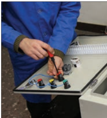
شکل ۹۳- سیم‌کشی چراغ‌های سیگنال
