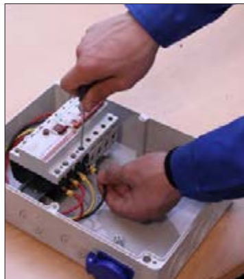
شکل ۲۲- نصب کلید جریان باقیمانده (نشتی)
