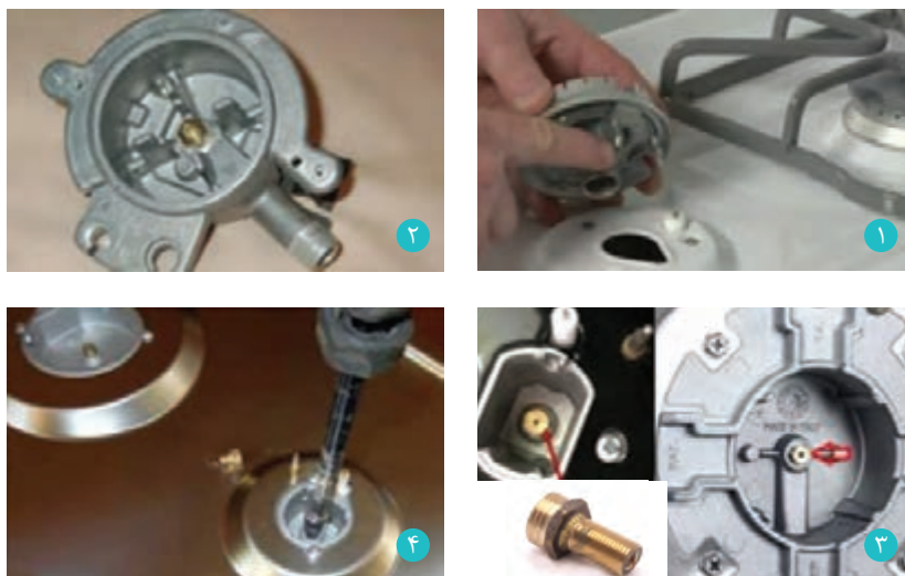
شکل ۴-۷- مراحل تعویض ژینگلور یا پستانک گازی
