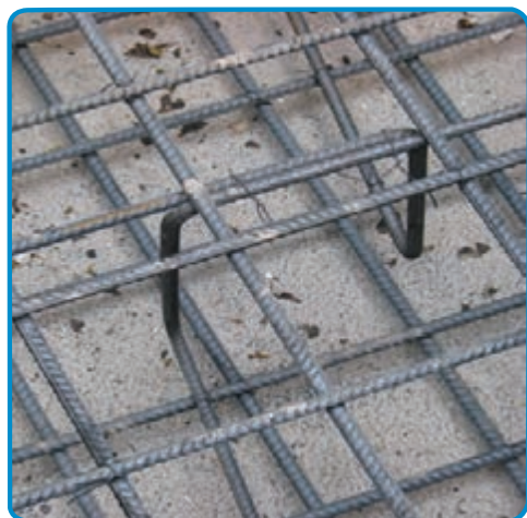
شکل ۳-۵۳- استفاده از خرک در میلگرد گذاری پی
