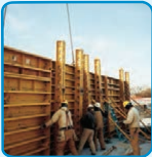
شکل ۳-۳۶- قالب فایبر گلاس برای اجرای دیوار بتنی
