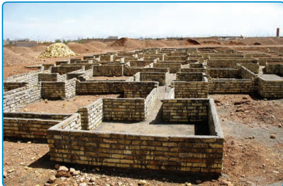
شکل ۱۵-۳- استفاده از قالب آجری برای اجرای پی
