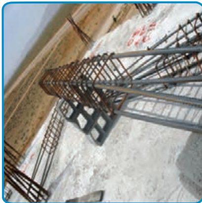
شکل ۷-۲۲- آماده کردن میلگردهای تیر روی زمین
