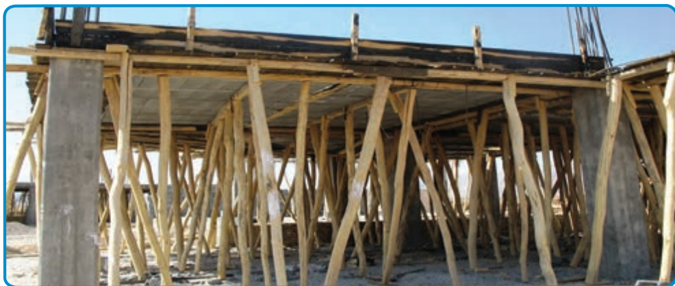
شکل ۳-۲۴- استفاده از شمع‌های چوبی جهت نگهداری قالب‌ها
