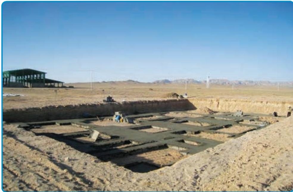
شکل ۳-۶- گودبرداری در زمین‌های نامحدود
