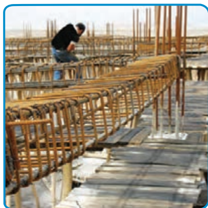
شکل ۷-۲۴- تنظیم فاصله بین خاموت ها
