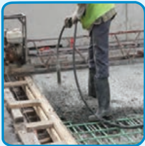
شکل ۱۴-۳- وایبراتور یا لرزاننده بتن داخل قالب
