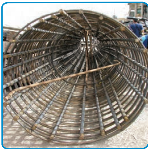
شکل ۲۰-۷- میلگرد گذاری مارپیچ در ستون
