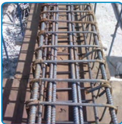
شکل ۷-۲۵- بستن خاموت ها با مفتول
