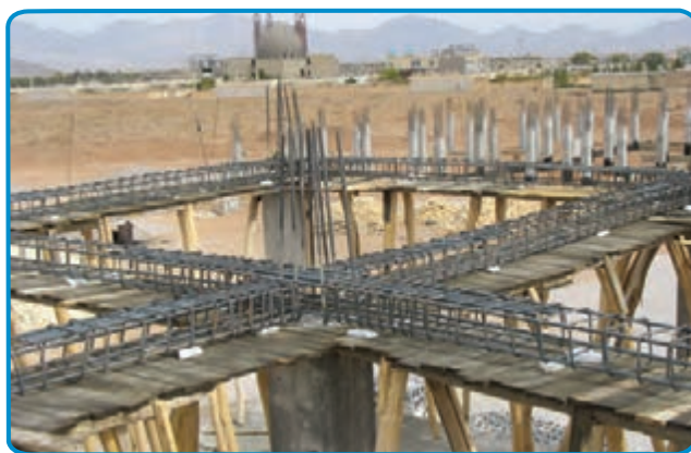
شکل ۷-۲۷- رعایت فاصله پوشش بتنی در کف
