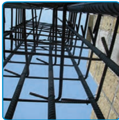
شکل ۱۹-۷- کار گذاشتن میلگردهای انتظار ستون، در فونداسیون
