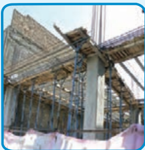
شکل ۳-۳۹- استفاده از قالب چوبی برای اجرای تیر
