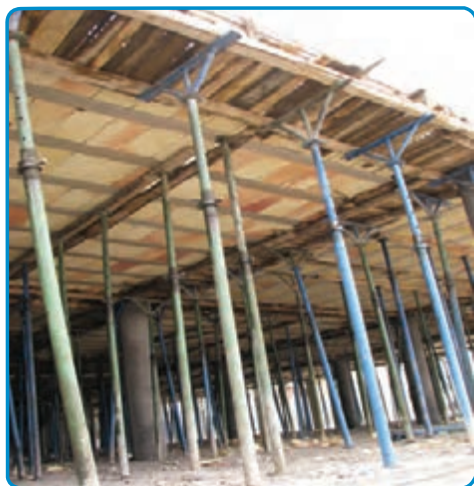
شکل ۳-۲۱- استفاده از شمع‌های فلزی جهت نگهداری قالب‌ها
