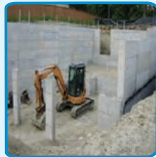
شکل ۲۱-۲- دیوار باربر
