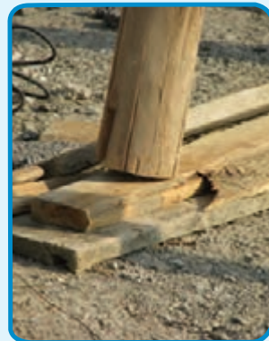
شکل ۳-۲۵- استفاده از گُوه جهت تنظیم ارتفاع
