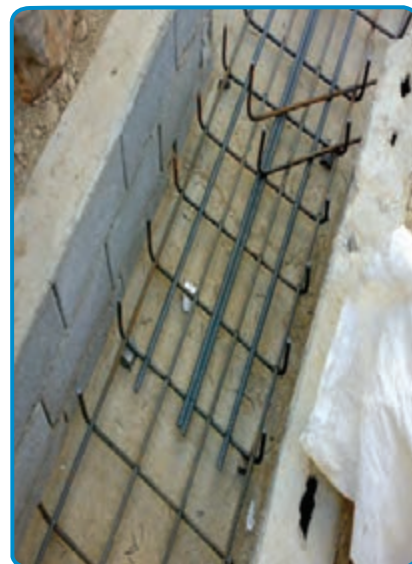
شکل ۷-۱۱- قرار دادن میلگردهای تقویتی
