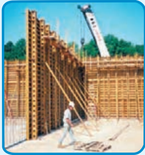
شکل ۱۹-۳- فایبر گلاس برای اجرای دیوار بتنی
