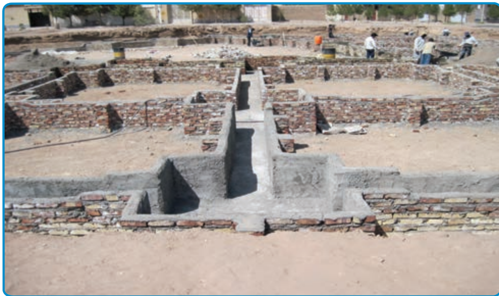
شکل ۳-۲۹- قالب آجری برای اجرای پی
