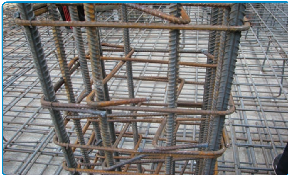
شکل ۵۰-۳- کاربرد سنجاقک در میلگرد گذاری ستون
