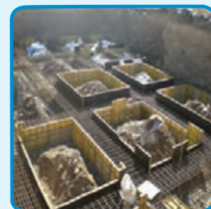
شکل ۳-۳۱- قالب فایبرگلاس برای اجرای پی
