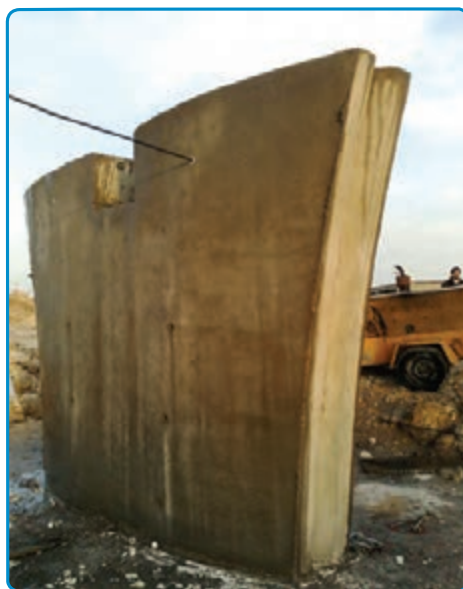
شکل ۳-۴۲- قالب برداری
