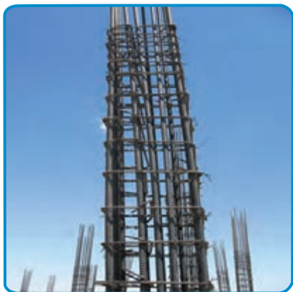
شکل ۱۹-۷- کار گذاشتن میلگردهای انتظار ستون، در فونداسیون
