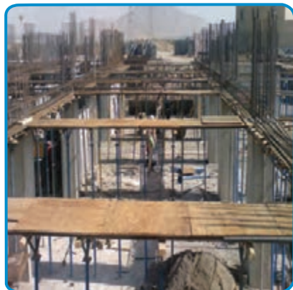
شکل ۷-۲۱- قالب بندی تیرها
