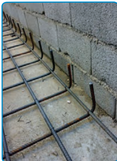
شکل ۷-۱۰- رعایت پوشش بتن در کف و بدنه
