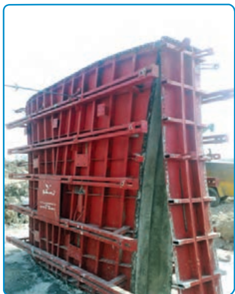
شکل ۳-۴۲- قالب برداری
