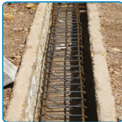
شکل ۵-۷- اجرای میلگرد شناژها
