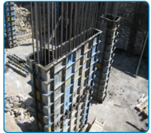
شکل ۳-۳۵- قالب فلزی برای اجرای دیوار بتنی
