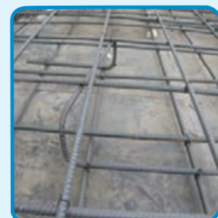
شکل ۳-۵۵- استفاده از خرک در میلگرد گذاری دال
