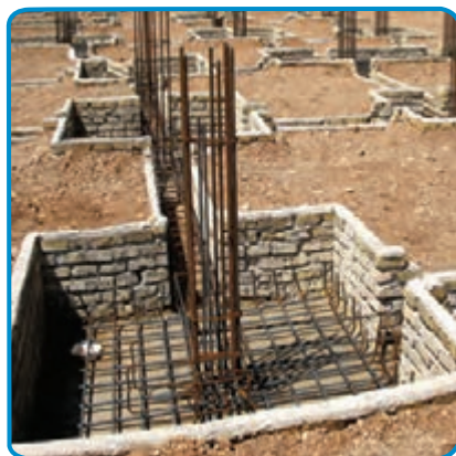
شکل ۴-۷- اجرای میلگردهای ریشه انتظار
