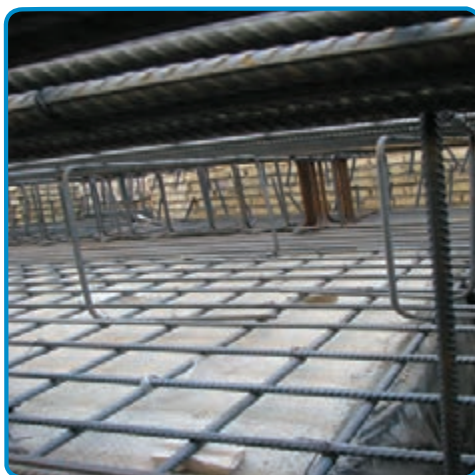
شکل ۳-۵۳- استفاده از خرک در میلگرد گذاری پی
