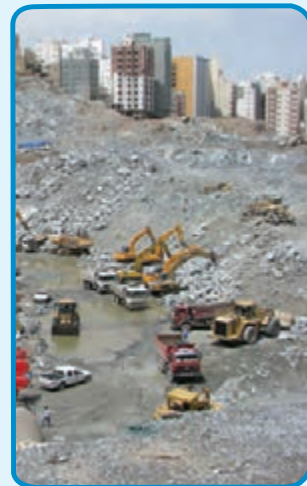
شکل ۳-۷- گودبرداری در زمین‌های نامحدود
