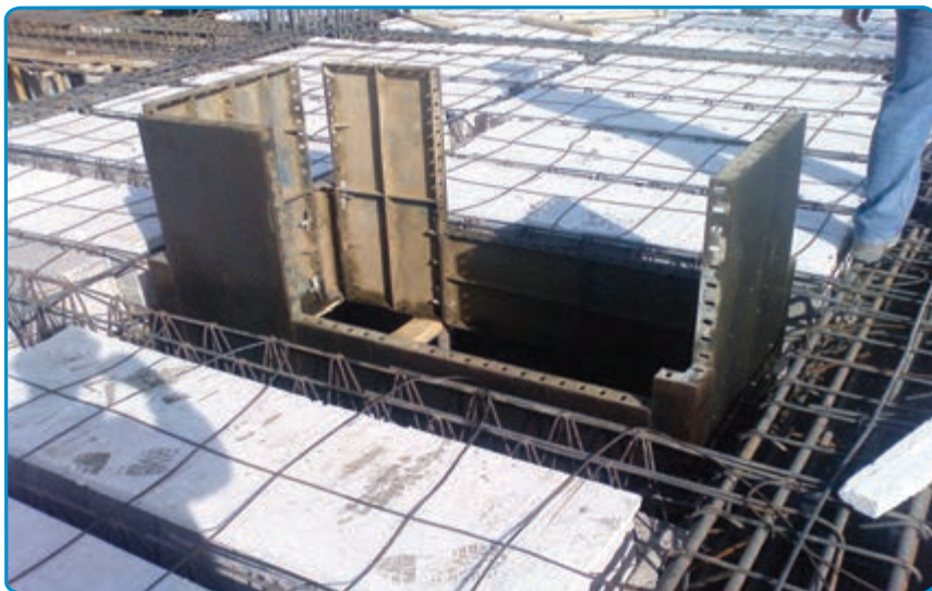
شکل ۳۵-۷- تکمیل قالب بندی
