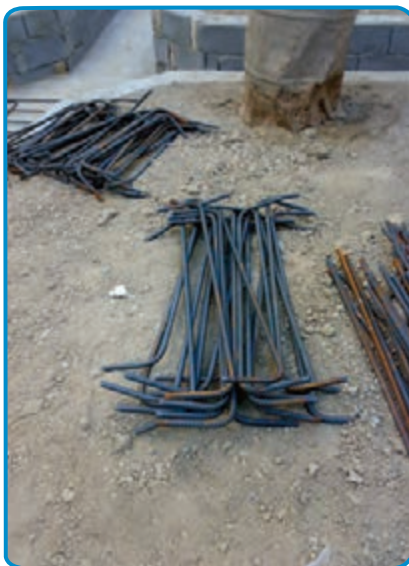
شکل ۷-۷- آماده کردن میلگردهای طولی و عرضی
