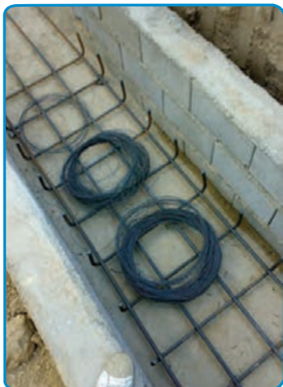
شکل ۷-۹- به هم بستن میلگردها
