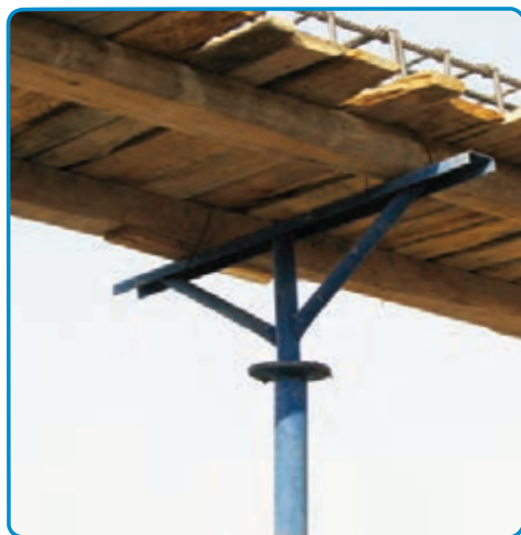
شکل ۳-۲۱- استفاده از شمع‌های فلزی جهت نگهداری قالب‌ها
