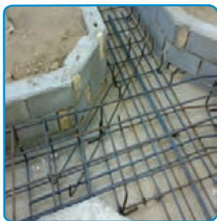
شکل ۱۳-۷- قرار دادن میلگردهای تقویتی پخ‌ها
