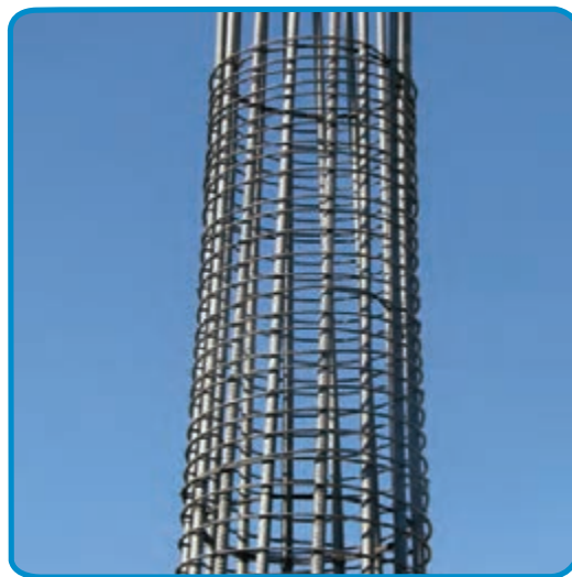
شکل ۲۰-۷- میلگرد گذاری مارپیچ در ستون
