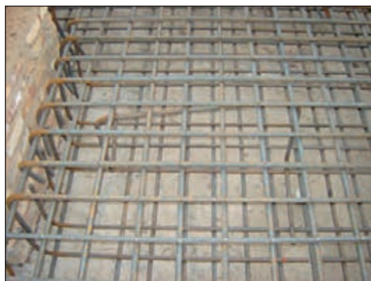
شکل ۱۴۷-۲ پی نواری و آرماتورگذاری آن
