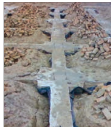
شکل ۷۳-۲ پی و شناژ بعد از بتن ریزی
