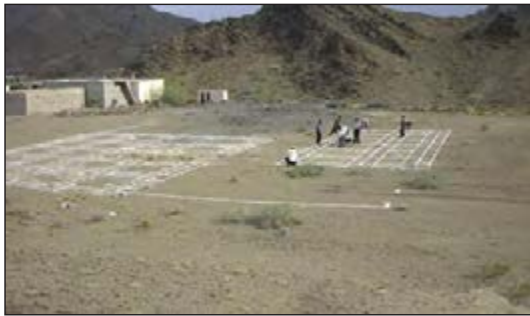
شکل ۸۳-۱ پیاده کردن نقشه روی زمین
