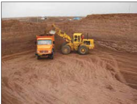
شکل ۸۵-۱ گودبرداری با لودر در زمین نامحدود
