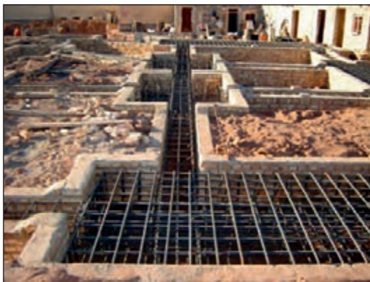
شکل ۷۰-۲ میلگردگذاری در پی کلاف بندی
