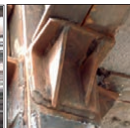
اتصال تیر به ستون به صورت لچکی
