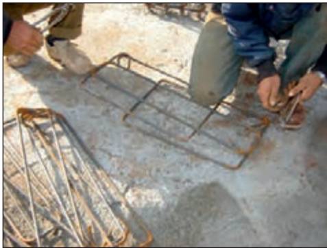
شکل ۲-۱۴۰ خم آرماتور و ساخت خاموت
