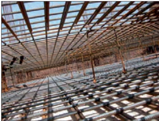
شکل ۲-۱۲۵ خرک بین دو شبکه‌ی میل‌گرد تحتانی و فوقانی از پی نواری
