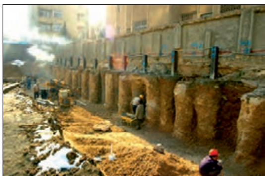
شکل ۱-۸۸ مهاربندی با پشت بند خاکی ستونی
