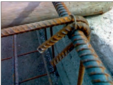
شکل ۲-۱۴۲ قلاب سرخاموت و بستن آن با مفتول
