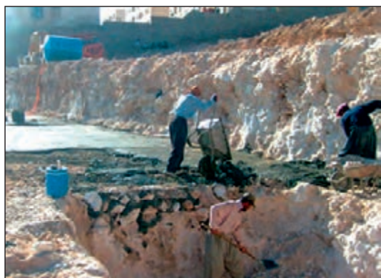
شکل ۱-۸۷ گودبرداری دستی (با بیل و کلنگ)
