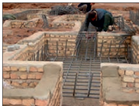
شکل ۱-۸۲ قالب‌بندی آجری در اطراف پی
