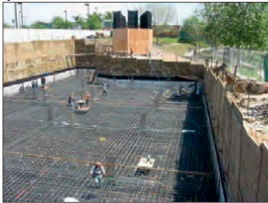
شکل ۱-۶۲ پی بتن مسلح یکپارچه (رادیه ژنرال)
