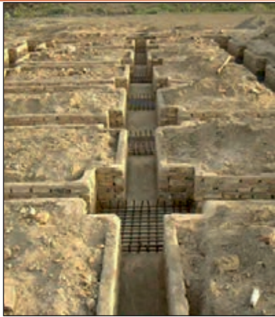
شکل ۴۸-۱ آرماتورگذاری پی تکی کلاف بندی شده
