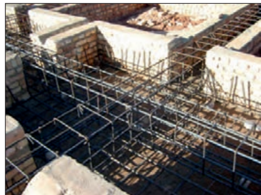
شکل ۷۱-۲ عبور میلگردهای شناژ در پی
