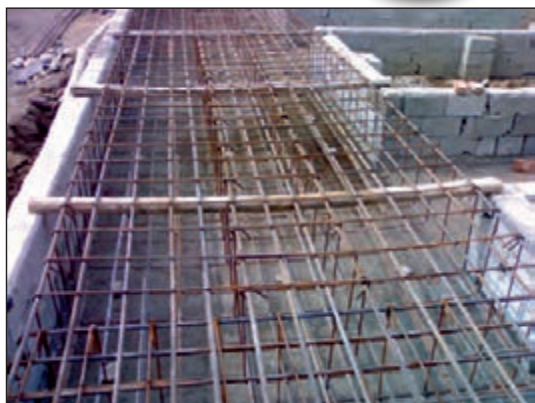
شکل ۱۴۶-۲ پی نواری و آرماتورگذاری آن
