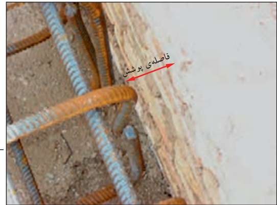
شکل ۲-۱۲۶ فاصله‌ی پوشش و قلاب سر میل‌گردها
