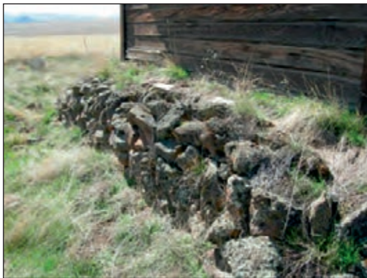
شکل ۱-۳۲ پی سنگی با سنگ لاشه
