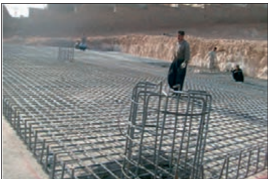
شکل ۱۵۲-۲ آرماتورگذاری پی صفحه‌ای با ستون‌های بتنی
