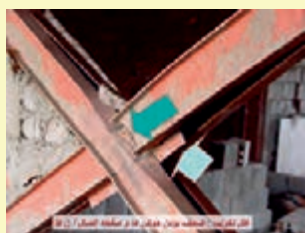
ضعیف بودن جوش و عدم اتصال مناسب
