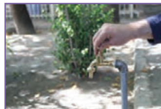
خ - آزمایش آب بندی شیر
