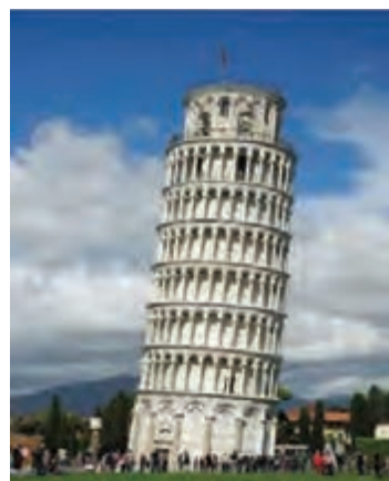
شکل ۱-۶- نشست نامتقارن پی در برج پیزا
