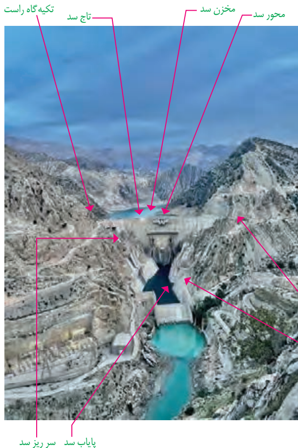
شکل ۱۷-۶-۱ نمای از بخش‌های مختلف یک سد
