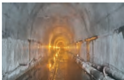
الف) پوشش‌های بتنی در معارها
