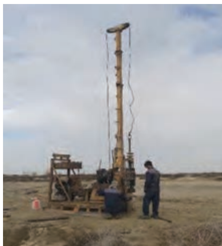
شکل ۶-۳- حفاری گمانه اکتشافی توسط دستگاه حفاری
