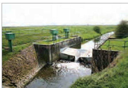
شکل ۳-۲. ایستگاه اندازه گیری آبدهی رود
