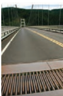
(ب) نمونه‌ای از بست‌های انبساطی
