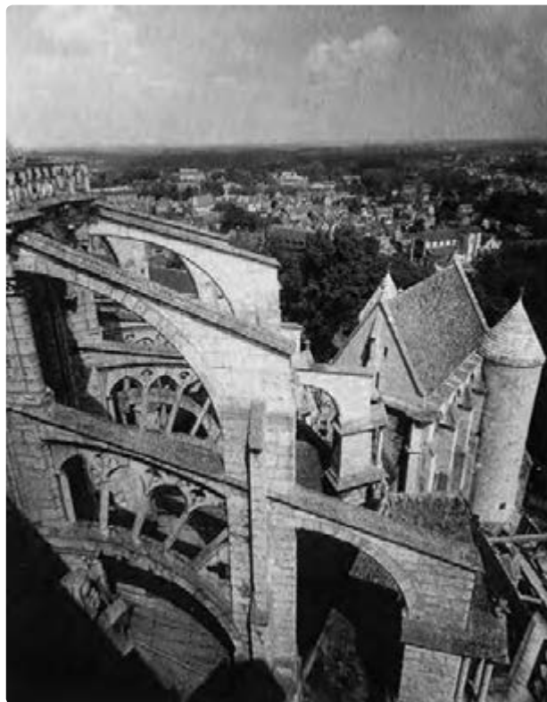
تصویر ۳۴- خایل‌های توخالی دیوارها در معماری گوتیک
