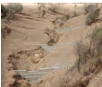
شکل ۱-۶۳ بند گابیونی (سنگ ها در تور سیمی)
