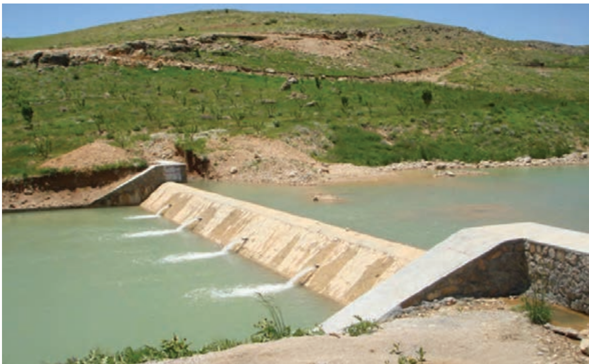
شکل ۲۶-۱- پروژه آبخیزداری بندسنگی ملاتی سرچنار
