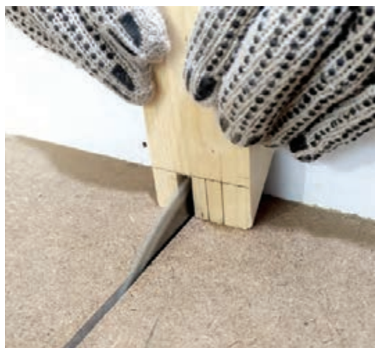
شکل ۳۴- خالی کردن محل اتصال قلیف با اره گرد
