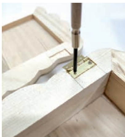
شکل ۵۷- بستن پیچ‌های لولا
