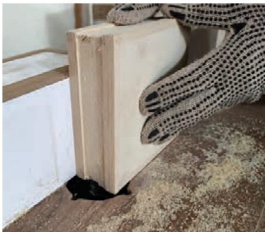
شکل ۲۹- خالی کردن سطح جعبه برای جوک
