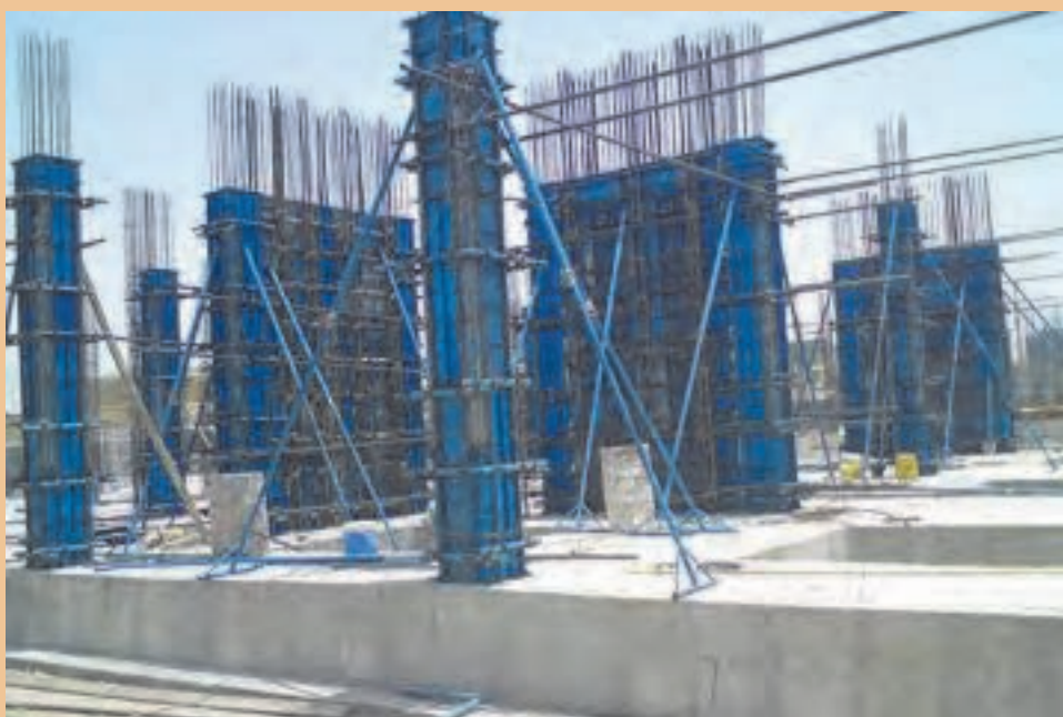
قالب‌بندی و آرماتوربندی ستون
