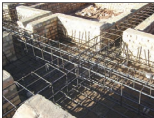
شکل ۳-۱۳۵ عبور میلگردهای شناژ در پی
