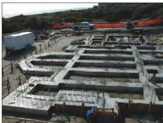
شکل ۳-۶۲ پی بتن مسلح نواری شبکه ای زیرستون
