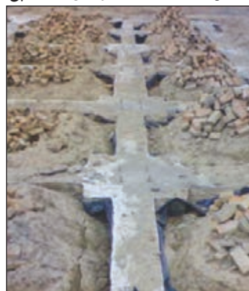
شکل ۳-۱۳۷ پی و شناژ بعد از بتن‌ریزی
