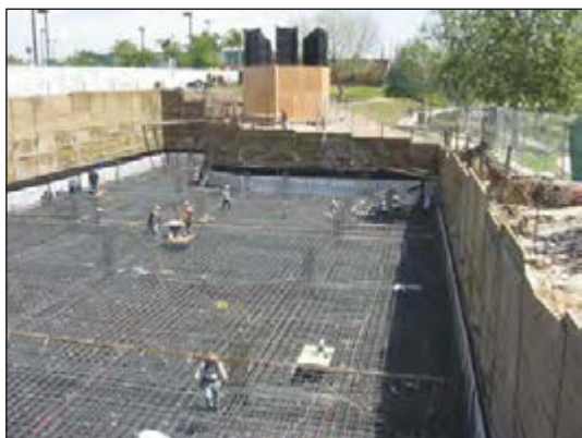
شکل ۳-۶۸ پی بتن مسلح یکپارچه (رادیه ژنرال)
