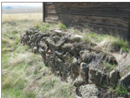
شکل ۳-۴۰ پی سنگی با سنگ لاشه
