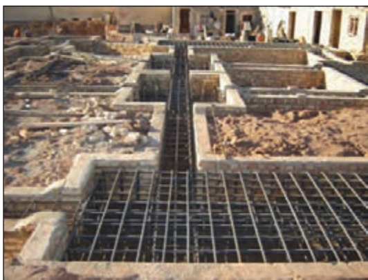
شکل ۳-۱۳۴ میلگردگذاری در پی کلاف‌بندی
