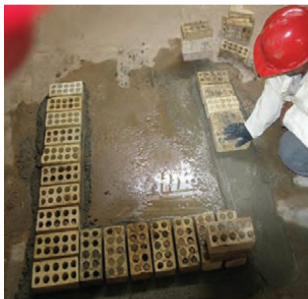
شکل ۱ - ۳۳ (ج): ریسمان کشی و چیدن ضلع سوم
