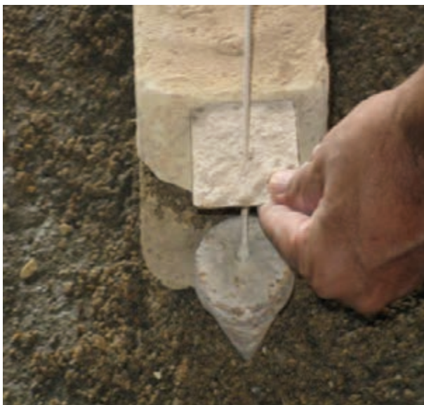
شکل ۱ - ۹۴ : شاقول کردن نبش کار
