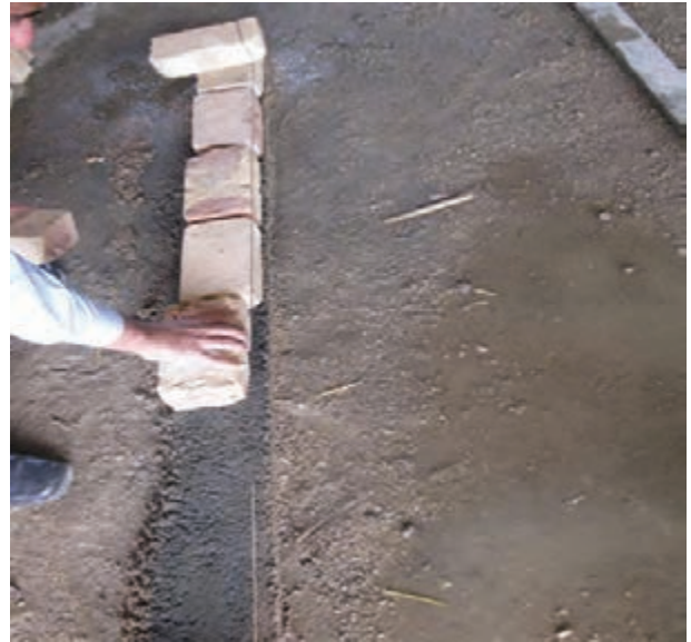
شکل ۱ - ۹۱ : نحوه چیدن آجر در امتداد ریسمان کار
