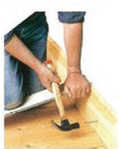
شکل ۳- ۲۹: نصب قرنیز چوبی با میخ
