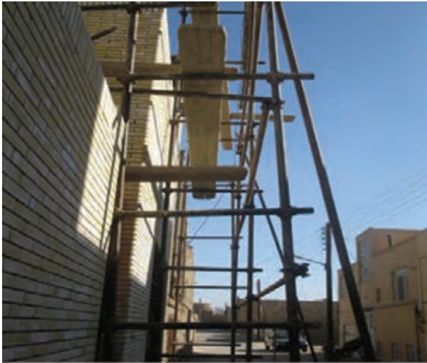
شکل ۱-۱: داربست فلزی برای چیدن دیوار
