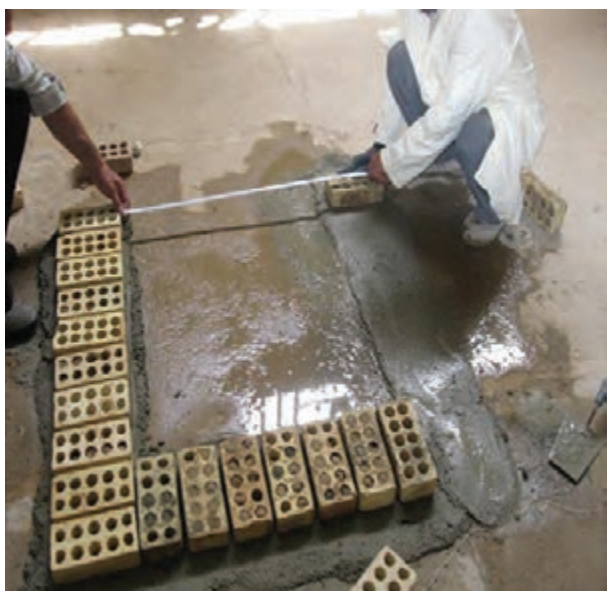
شکل ۱ - ۳۳ (ب): جدا کردن اندازه دو طرف دیگر
