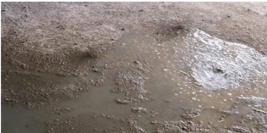
شکل ۱- ۶۷: خیس کردن سطح زیر کار
