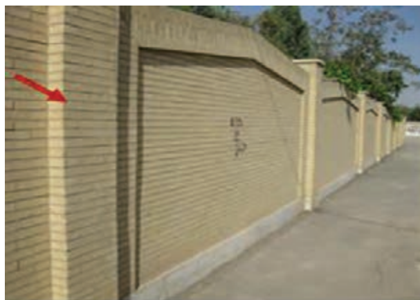
شکل ۱ - ۵۸: وابند در دیوار حصارکشی
