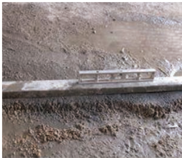
شکل ۱- ۶۹: تراز کردن روی ملات
