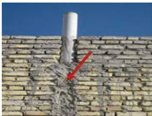
شکل ۱ - ۶۵: پر کردن درز لوله‌ها
