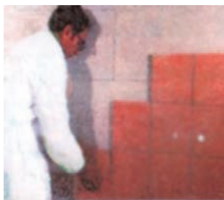
شکل ۱ - ۴۳: نصب کاشی روی قطعات پیش ساخته گچی
