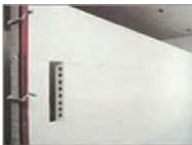
شکل ۱ - ۳۷: دیوار جداکننده با قطعات پیش ساخته گچی
