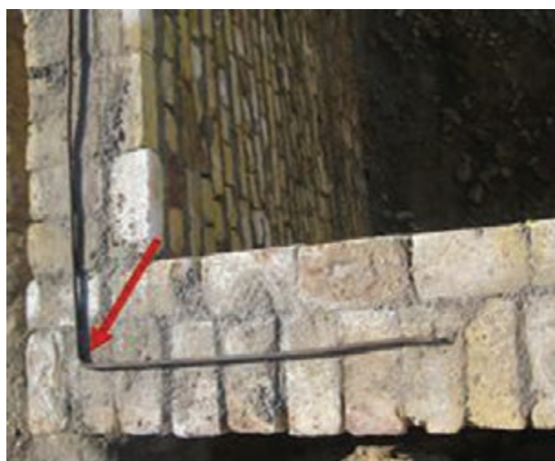
شکل ۱ - ۵۵: میلگرد گذاری در محل اتصال دو دیوار
