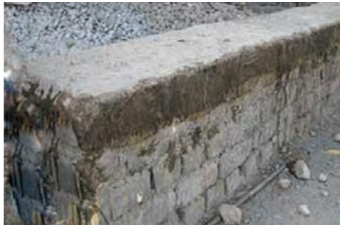
شکل ۱- ۲۹: کرسی چینی یا عایق کاری رطوبتی
