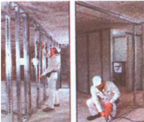
شکل ۱-۴۴: قاب سازی جهت اتصال روکش های گچی
