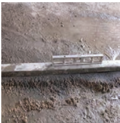
شکل ۱- ۱۰۵: تراز کردن روی ملات
