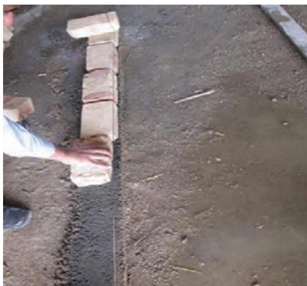
شکل ۱ - ۷۴: نحوه چیدن آجر در امتداد ریسمان کار
