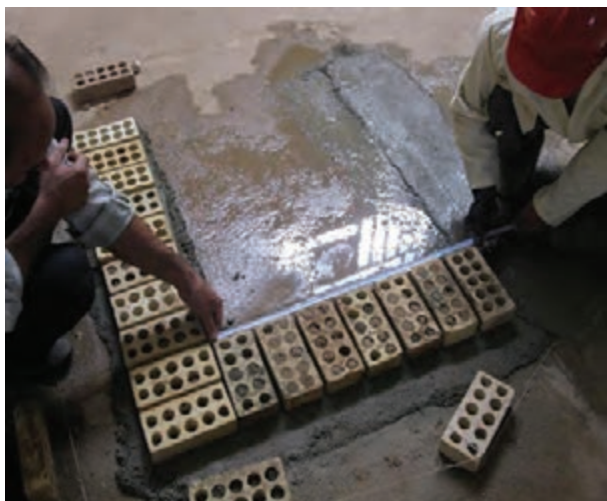
شکل ۱ - ۳۳ (الف): برداشتن طول دیوار
