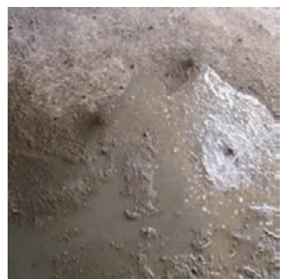
شکل ۱- ۱۰۳: خیس کردن سطح زیر کار
