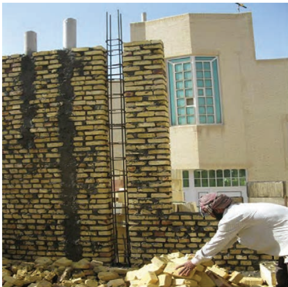
شکل ۱ - ۶۰: اتصال کلاف قائم و افقی در دیوار
