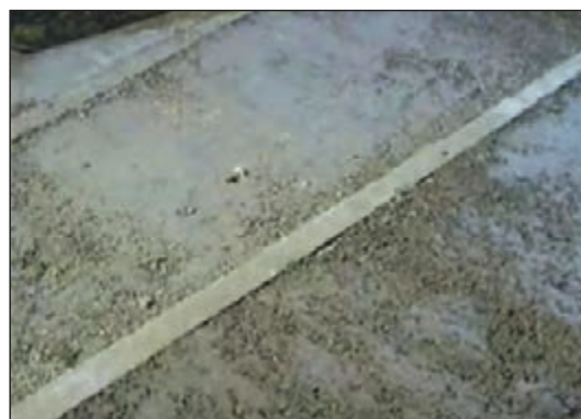
شکل ۲۱-۶ پرکردن فضای بین کرم‌ها با پوکه معدنی
