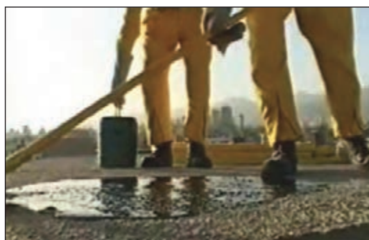
شکل ۲۲-۶ قیرگونی پس از پرکردن بین کُرم‌ها
