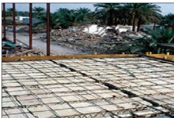
شکل ۱۳-۱ سقف تیرچه بلوک
