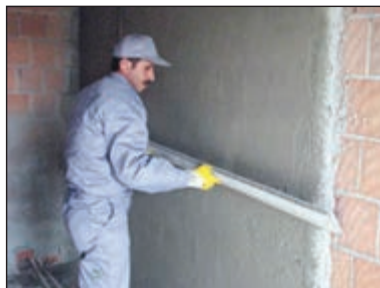
شکل ۸۵-۱ شمشه‌گیری
