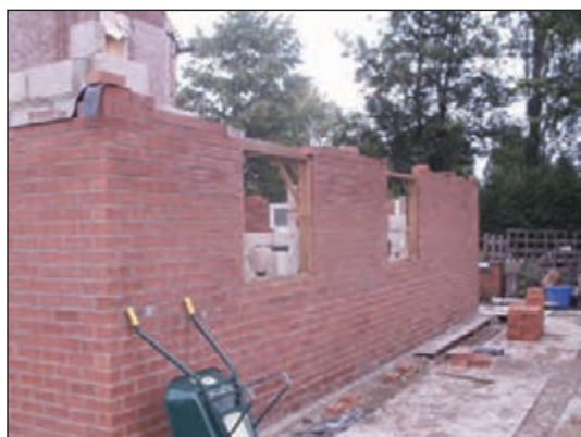
شکل ۱-۱۰۷ دیوار باربر آجری
