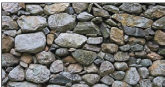
شکل ۱۳۶- دیوار سنگی خشکه چین
