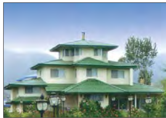
شکل ۱-۱۰۳ پوشش آزبستی
