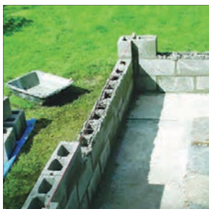
شکل ۱۵۰-۱ ساخت دیوار با بلوک های بتنی یا سیمانی
