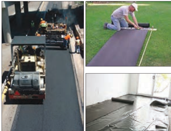
شکل ۴۴-۱ کاربرد قیر در آسفالت کاری و ایزوگام
