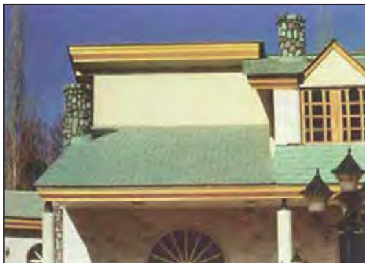
شکل ۱-۱۰۲ پوشش سقف با ورق‌های فشرده‌ی آردواز
