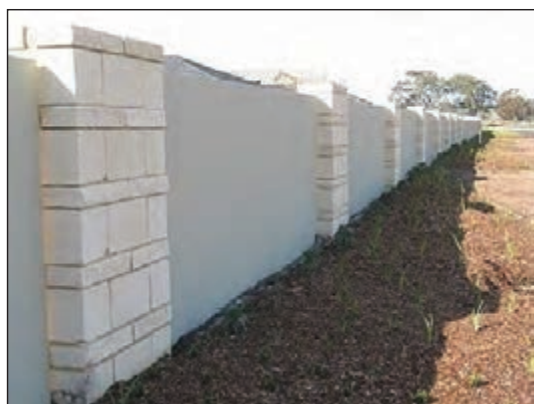
شکل ۱-۱۳۲ دیوار با ترکیب مصلّح سنگ و قطعات پیش ساخته‌ی بتّنی
