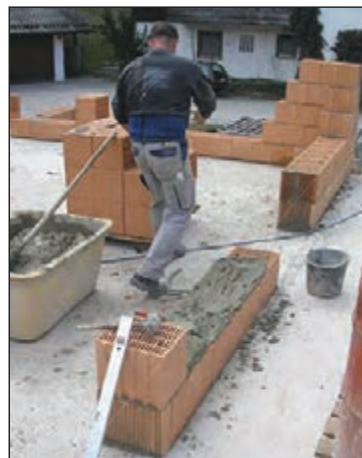
شکل ۱-۱۵۳ ساخت دیوار با بلوک سفالی
