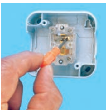
د - برقراری اتصال پلاتین با کنتاکت غیرمشترک ۲
