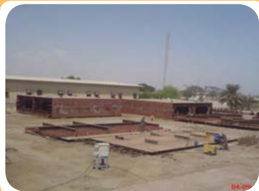
د) کارگاه ساخت اسکلت فلزی ساختمان
