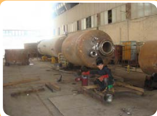
ب) کارگاه ساخت مخازن تحت فشار
