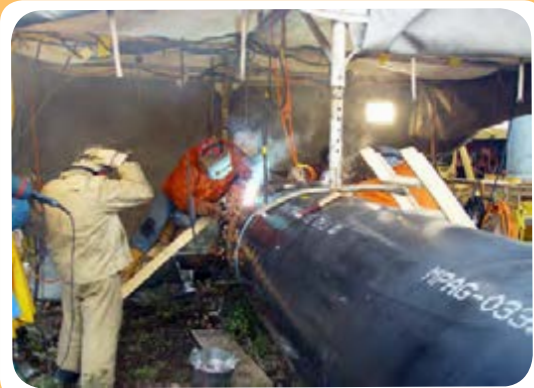
ن) کارگاه ساخت خط لوله
