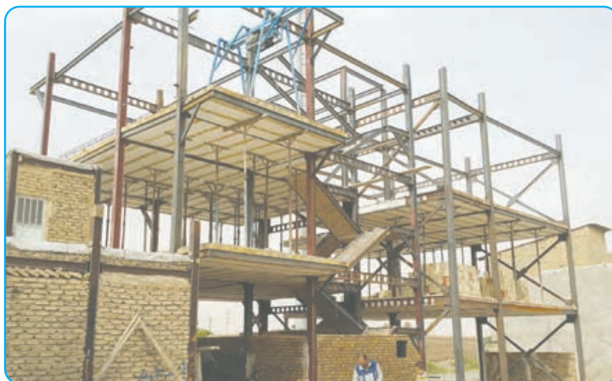
خانه‌ی در حال ساخت
