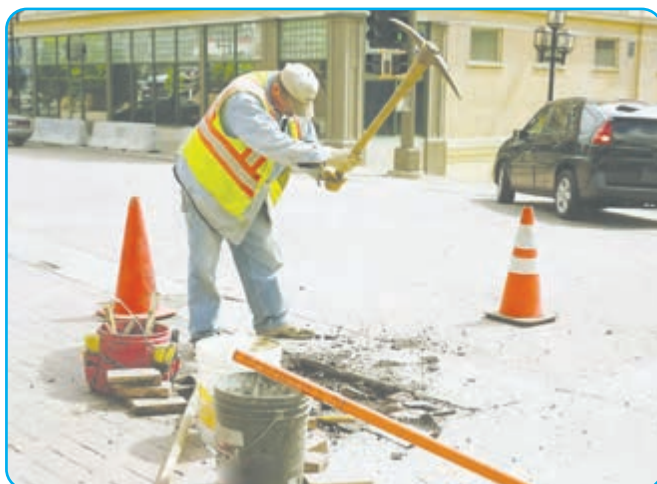
استفاده از کلنگ در کندن زمین
