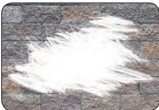
گچ روی دیوار
