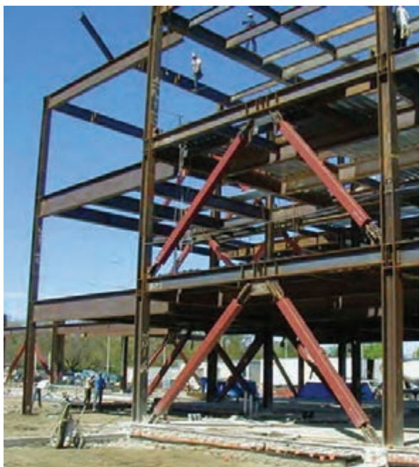
شکل ۵۰-۳ مقاوم سازی ساختمان‌ها در مقابل زمین لرزه
