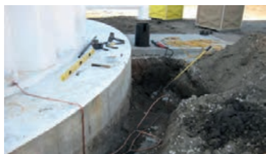
شکل ۴-۲۵- تخلیه الکتریسیته ساکن بدنه مخزن به زمین
