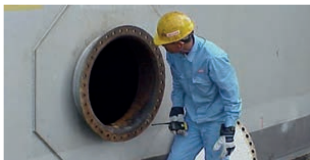
شکل ۴-۲۱- دریچه آدم رو مخزن
