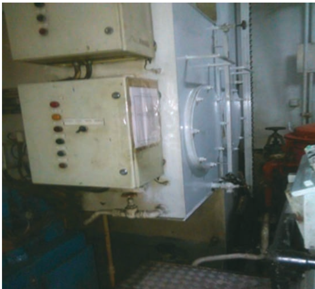
شکل ۲۳- مخزن سوخت روزانه یک شناور
