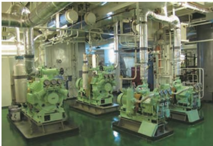
شکل ۱۹- کمپرسورهای هوا در ساختمان کشتی
