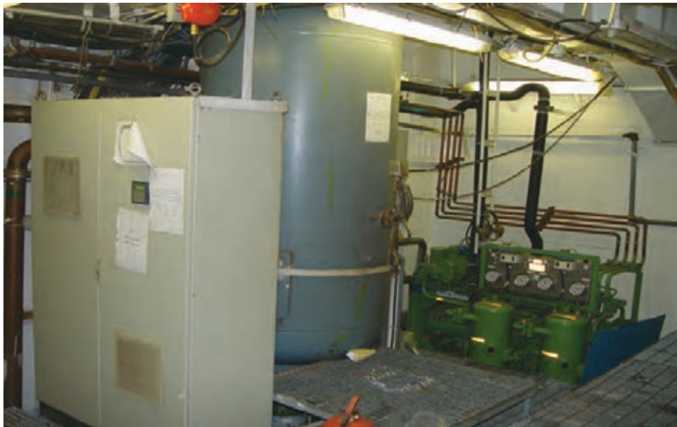
شکل ۱۷- سامانه هوای فشرده
