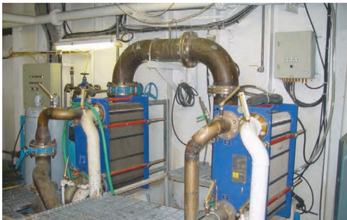
شکل ۶- سامانه خنک کاری آب دریا
