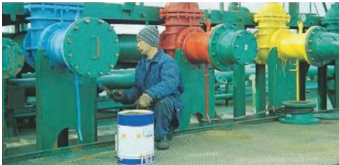
شکل ۵۵- رنگ آمیزی سامانه‌های لوله‌کشی بر روی عرشه
