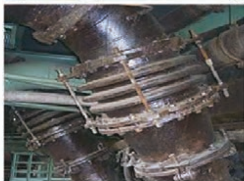
شکل ۴۳- اتصال‌های قابل انبساط
