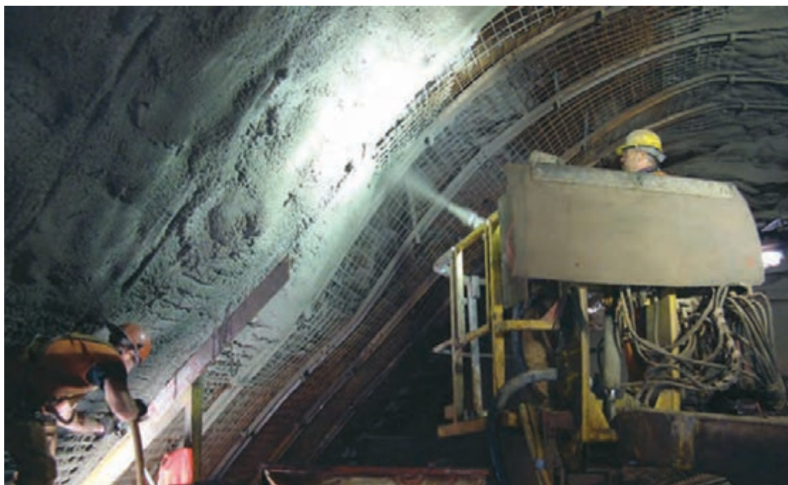
نگهداری به کمک پیچ سنگ، تور سیمی و تزریق سیمن در تونل اصلی معدن
