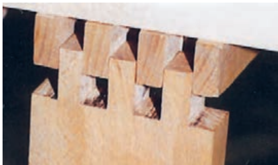
شکل ۱۲- اتصال انگشتی با تعداد زبانه فرد
