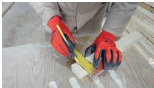
شکل ۵۲- اندازه‌گذاری به وسیله گونیا
