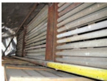
شکل ۳۸- نحوه قرارگیری کویل‌های حرارتی
