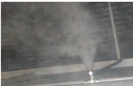
شکل ۳۴- نازل اسپری بخار
