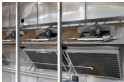
شکل ۴۰- انتقال حرارت کویل‌ها به وسیله فن‌ها
