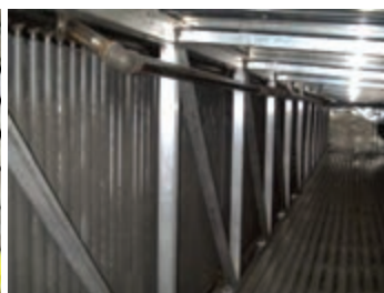
شکل ۳۸- نحوه قرارگیری کویل‌های حرارتی
