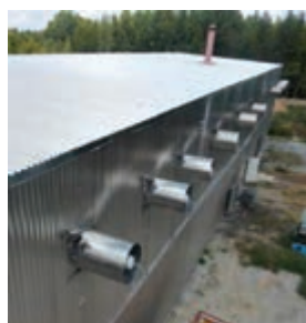
شکل ۴۳- نصب دمنده در خارج از کوره
