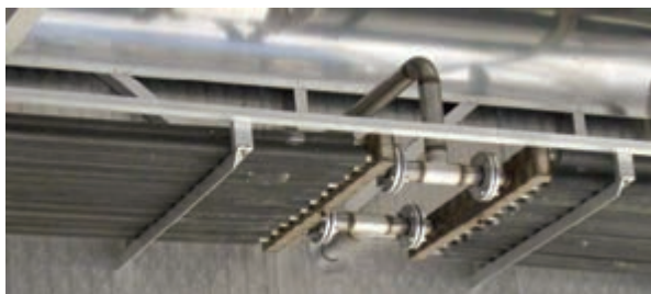
شکل ۴۱- انتقال حرارت کویل‌ها با هوای اطراف خود
