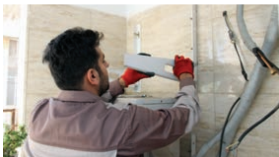
شکل ۷- نصب یونیت خارجی
