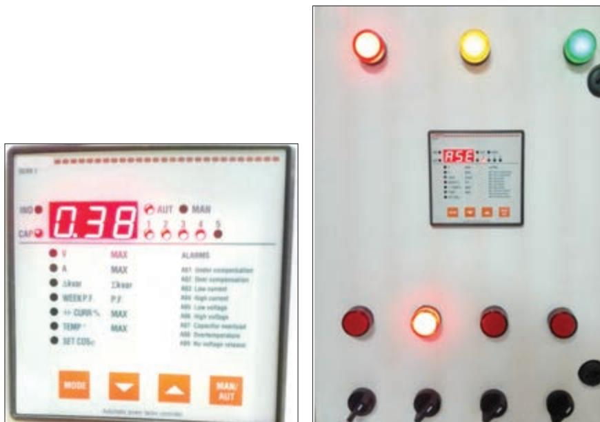
شکل ۲۱- روند شناسایی اتوماتیک توسط رگولاتور اصلاح ضریب توان
