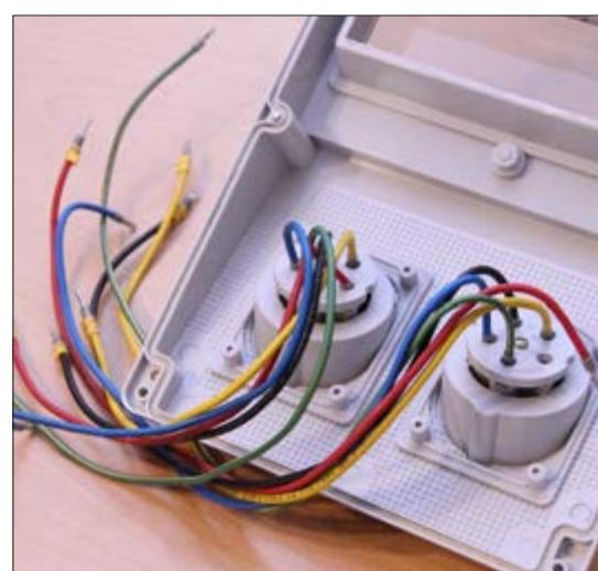
۴- اکنون از خروجی فاز سوم کلید خودکار مینیاتوری سه فاز دو رشته سیم به رنگ مشکی با شماره سیم L<sub>3</sub> به صورت موازی به ترمینال T سه فاز اتصال دهید. از خروجی کلید خودکار مینیاتوری تک فاز دو رشته سیم قرمز با شماره سیم L<sub>1</sub> به طور موازی به ترمینال R پریزهای تک فاز اتصال دهید (شکل ۲۴).
