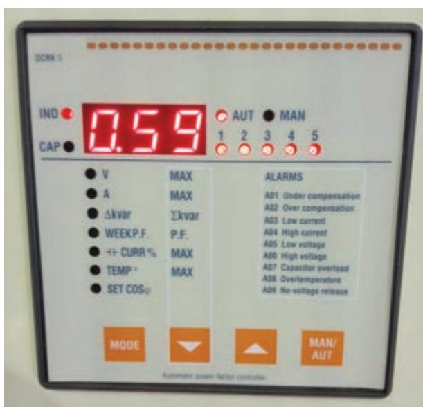
شکل ۲۳- نتیجه عملکرد رگولاتور اصلاح ضریب توان به خارج کردن یک پله
