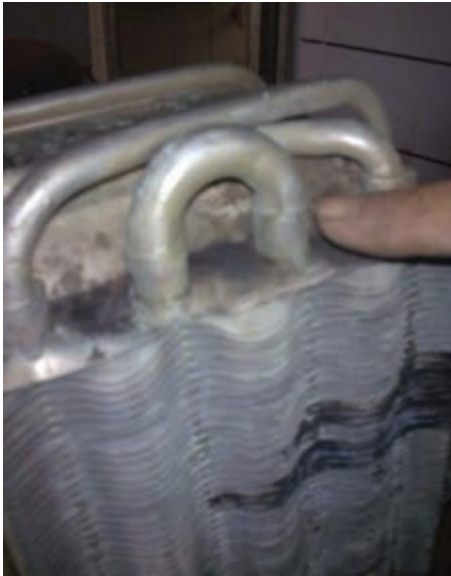
شکل ۱۱- تشکیل رسوب در آب گرم‌کن
