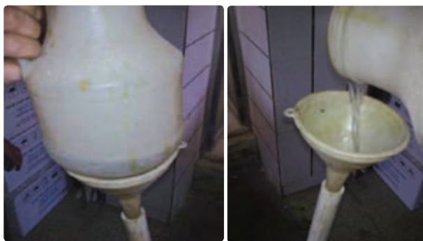
شکل ۱۸- شست‌وشوی مبدل بعد از رسوب‌زدایی
