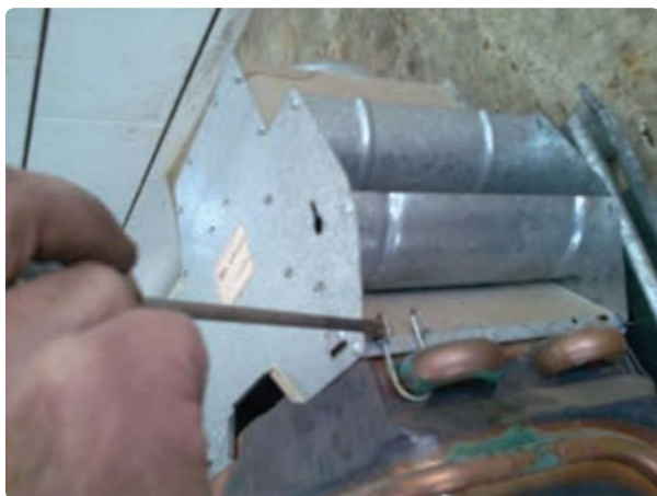
شکل ۶- جدا کردن کلاهک تعدیل از مبدل
