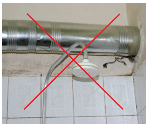
شکل ۳-۱۱ عبور غیر مجاز دودکش
