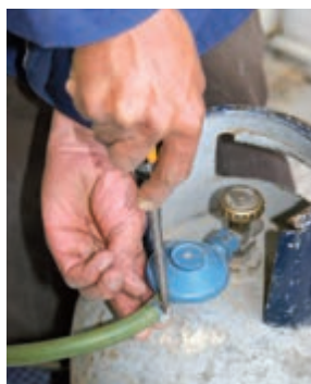
شکل ۱-۶۶ ب سفت کردن بست
