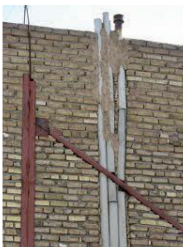
شکل ۴-۶ الف دودکش نادرست
