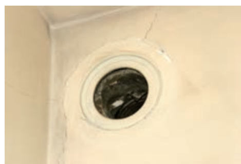
شکل ۱-۴ دودکش در محل نصب آب گرم کن.
