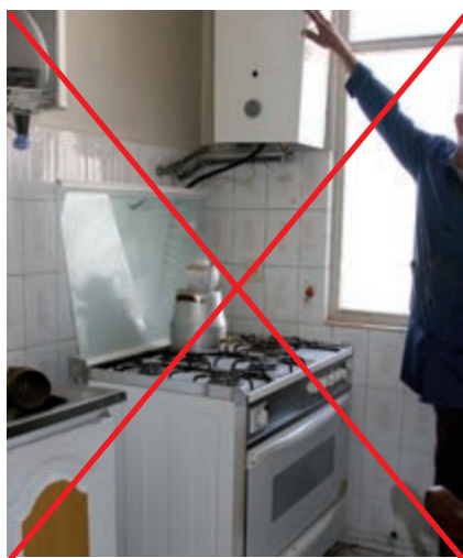
شکل ۱-۶ نصب نادرست آب گرم کن.
