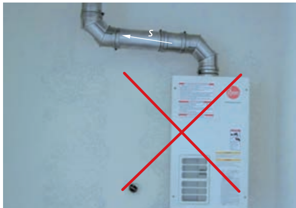
شکل ۱-۳۶ اتصال نادرست دودکش
