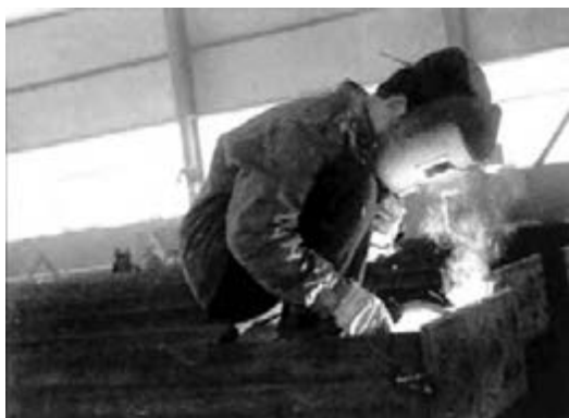
شکل ۲- جوشکاری با الکترودهای روکش دار
