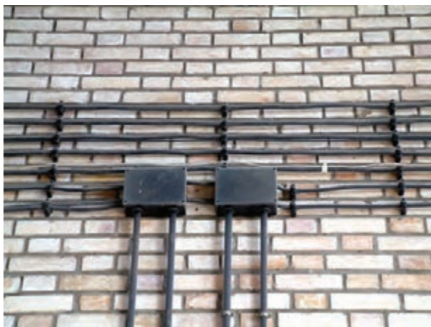
شکل ۵-۵۷- کابل‌کشی روی دیوار
