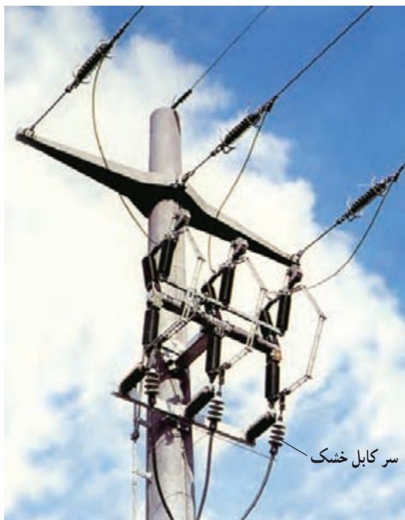
شکل ۶-۶- سر کابل خشک حرارتی هوایی
