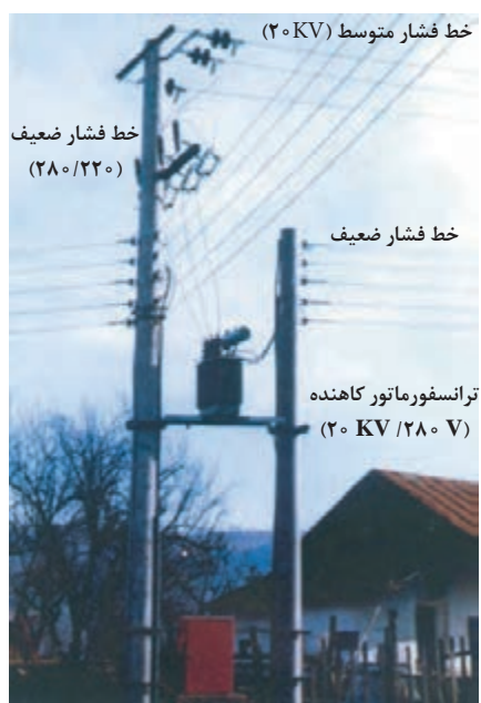
شکل ۲۷- خطوط فشاری متوسط و ضعیف هوایی برق
