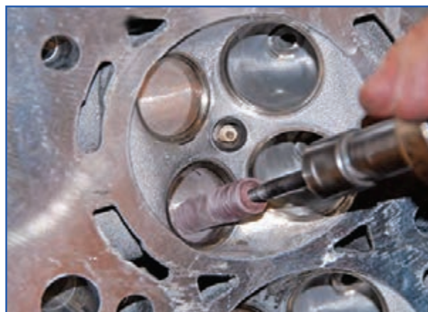
الف) نحوه تمیز کردن محفظه پشت سوپاپ
