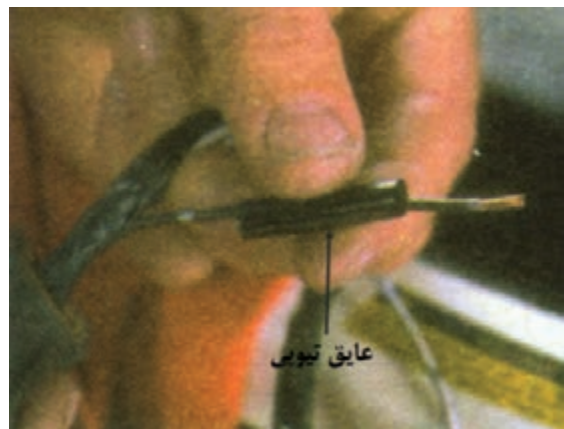
شکل ۶-۶۳- وارد کردن سیم به داخل عایق تیوبی
