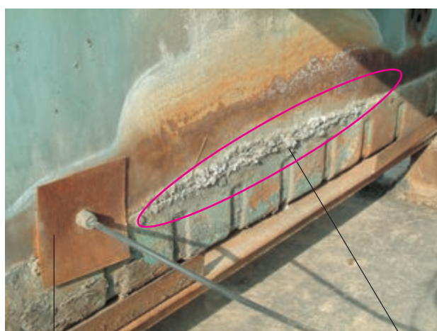
رسوب های آب تعمیر غیراساسی شکل ۸-۱۷۶
