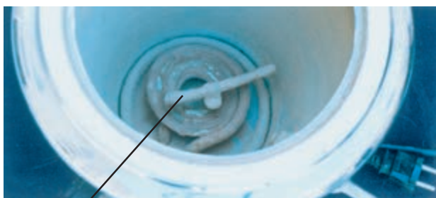
شکل ۲-۲۲ بلوی ترموستات گازی
