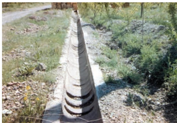
شکل ۲-۲- کانال با مقطع دوزنقه‌ای
