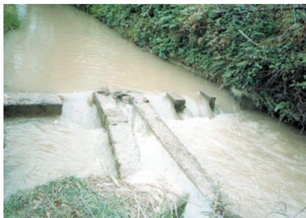
شکل ۸-۲- مقسم ثابت
