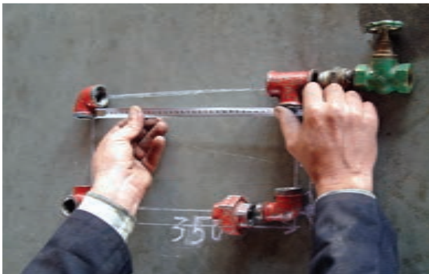
شکل ۵-۱۱۲- اندازه‌گیری طول لوله
