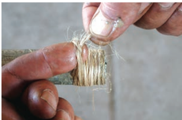
شکل ۵-۵۵ گره زدن انتهای پیچیدن کنف
