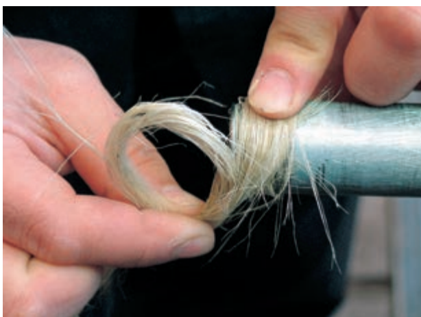
شکل ۵-۱۳۸- پیچیدن مواد آب‌بندی به سردنده‌ها
