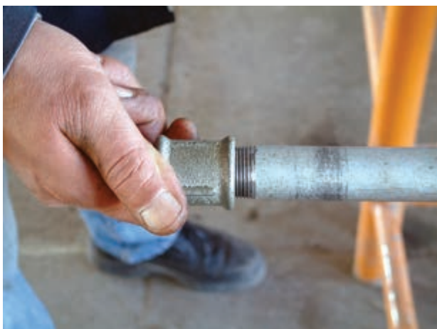
شکل ۴-۴۱ کنترل بار سردنده به وسیله‌ی یک فیتینگ
