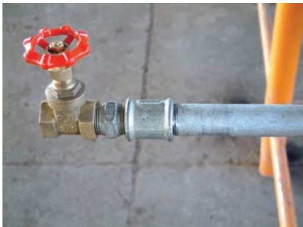
شکل ۴-۸- اتصال دنده‌ای
