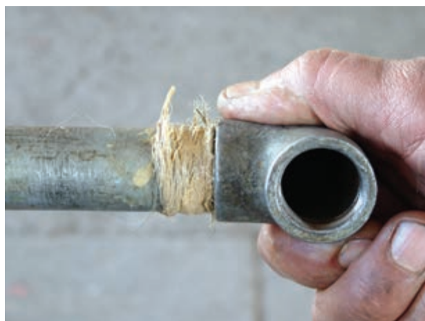
شکل ۹۱-۵- بستن فیتینگ بر روی سردنده
