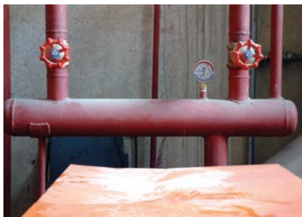
شکل ۳۲-۵- استفاده از اتصال جوشی در حرارت مرکزی
