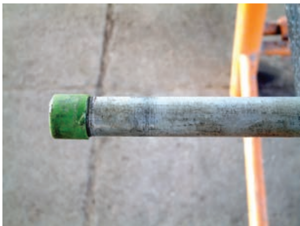
شکل ۴-۱۶ - اتصال بوشن پلاستیکی به سردنده‌ی لوله
