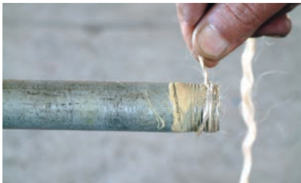
شکل ۵-۵۴ پیچیدن کنف بر روی سردنده
