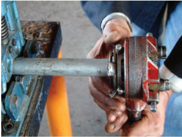
شکل ۴-۳۹ باز کردن فلک‌های چهارنظام
