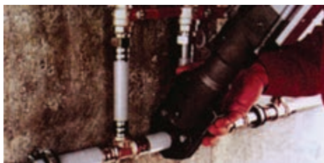
شکل ۵-۲۳ - اتصال پرسی
