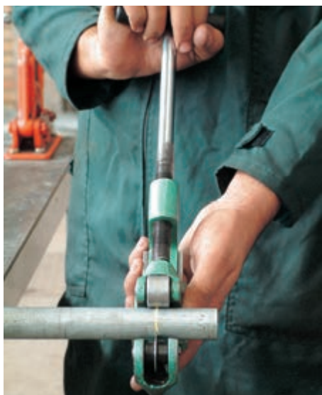
شکل ۱۳۵-۵ بریدن لوله‌های مورد نیاز
