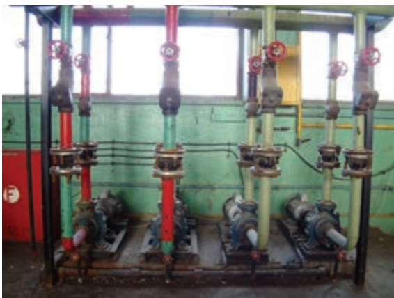
شکل ۵-۳- کاربرد لوله درزدار در لوله‌کشی شوفاز
