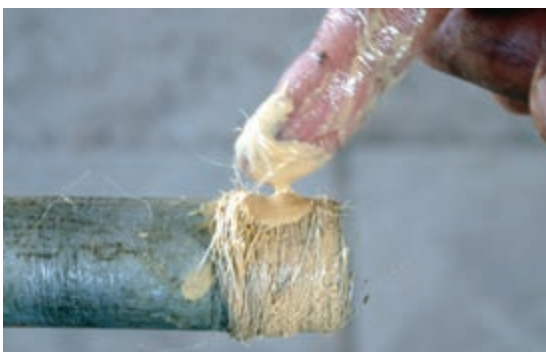
شکل ۱۵۲-۵- خمیر و کنف کردن سردنده‌ها
