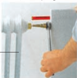
دنباله‌های شیر رادیاتور در اندازه‌های مختلف
