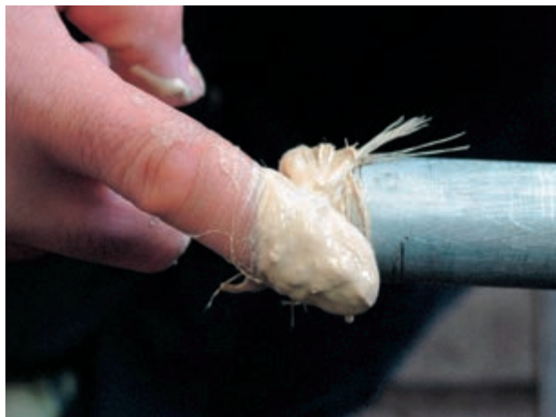
شکل ۹۰-۵- خمیر و کف کردن سردنده
