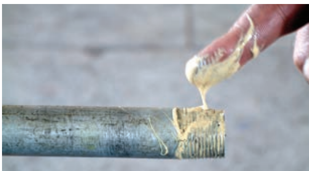
شکل ۵-۵۳- مالیدن خمیر بر روی سردنده
