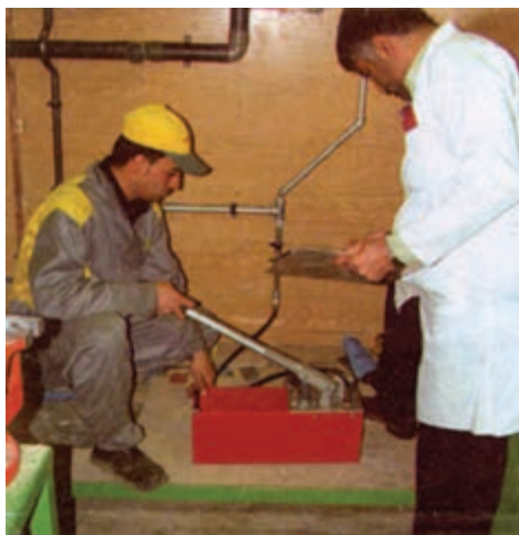
شکل ۵-۹۳- نحوه‌ی آزمایش با پمپ آزمایش دستی
