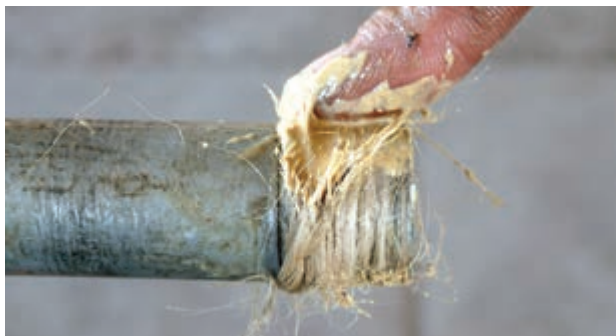
شکل ۵-۵۷ مالیدن خمیر آب بندی بر روی کنف
