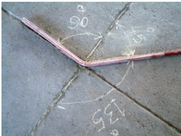
شکل ۲۹-۳- کنترل خم لوله‌های ۴۵ درجه
