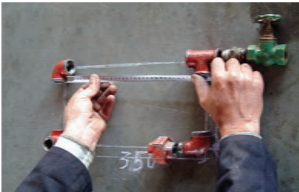
شکل ۱۴۹-۵- اندازه گیری طول لوله ها
