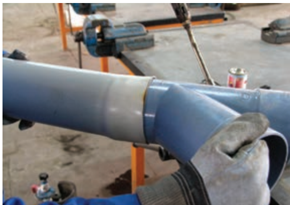
شکل ۲-۱۰ خارج کردن فیتینگ از سرکاسه
