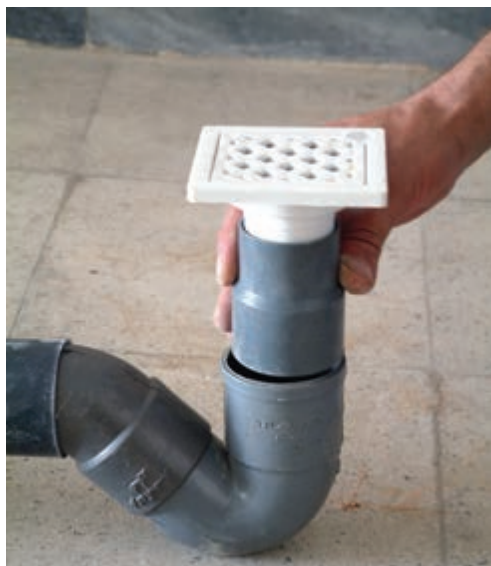
شکل ۳-۱۹- اتصال کف شوی به وسیله ی تبدیل
