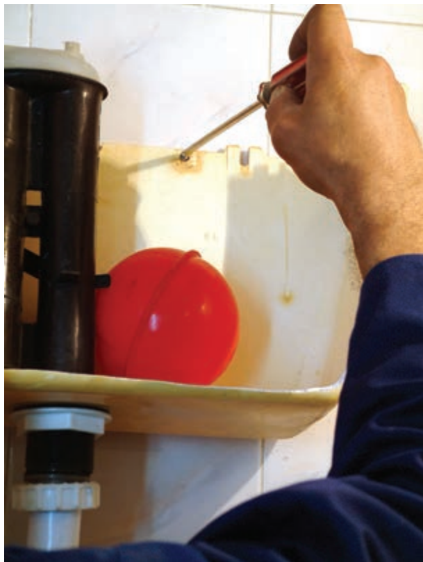
شکل ۲۱۳-۳ نصب مخزن فشاری به دیوار
