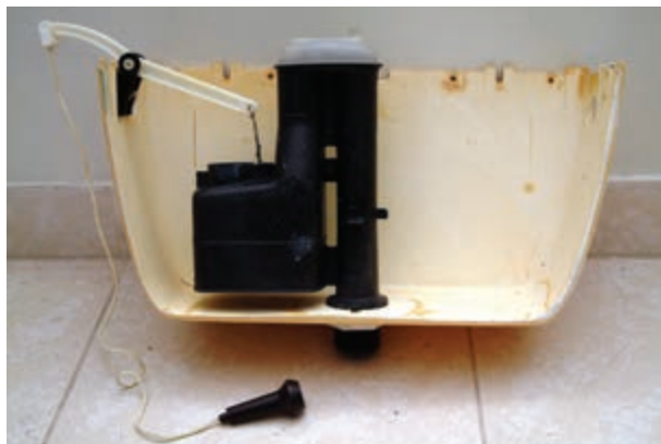
شکل ۳-۲۰۷- نصب پمپ تخلیه درون مخزن فشار
