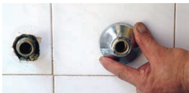
شکل ۲-۱۸۷- اتصال کاسه‌ها به دنباله‌ها
