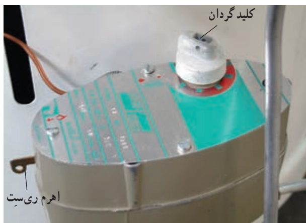
شکل ۱-۳۸- کاربراتور آب گرمکن نفت سوز
