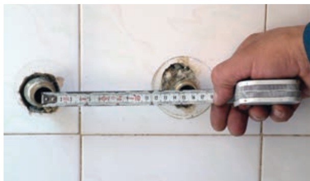
شکل ۲۰۲-۲- کنترل نمودن فاصله‌ی دنباله‌ها به وسیله‌ی متر
