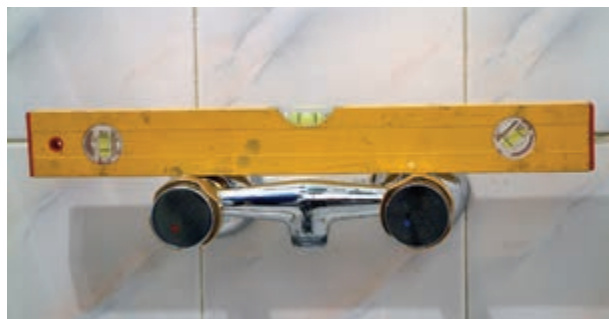
شکل ۲-۱۹۰- سنجش تراز بودن شیر مخلوط
