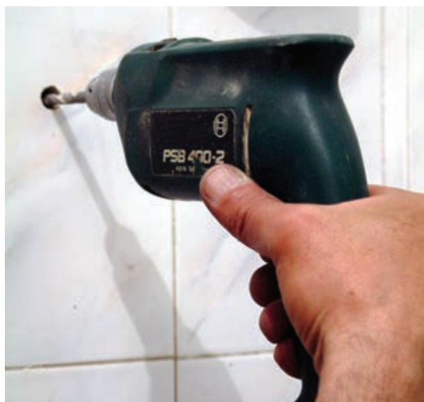
شکل ۳-۴۱ سوراخ کاری محل نصب پیچ ها
