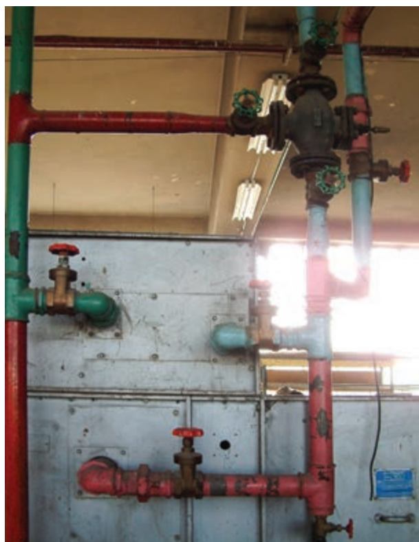
شکل ۲-۸۳ – مورد استفاده‌ی شیر فلکه در تهویه‌ی مطبوع
