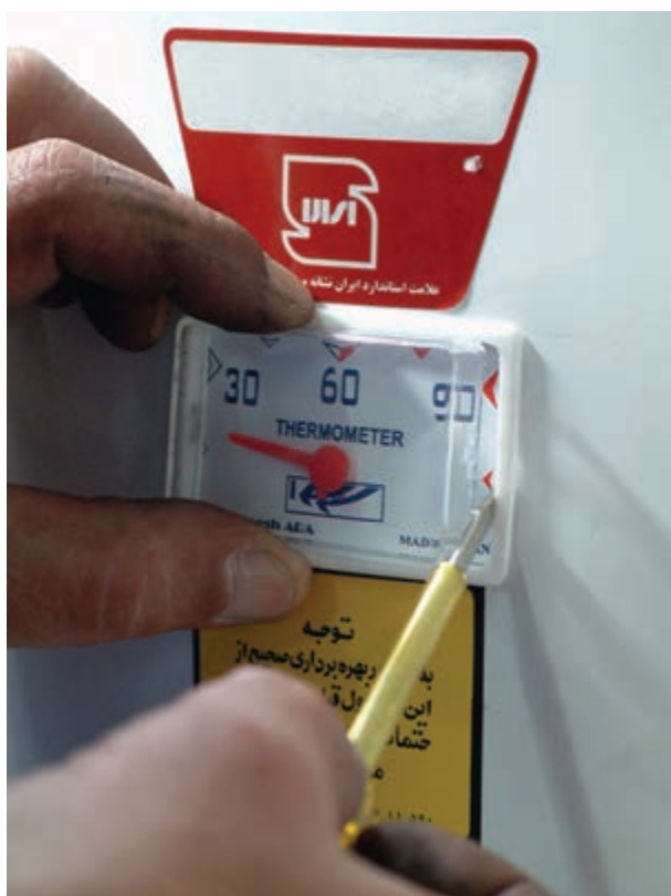
شکل ۱۱۶-۱ جدا کردن ترمومتر
