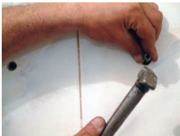
شکل ۳-۴۲ کوبیدن رولپلاک ها در درون سوراخ ها
