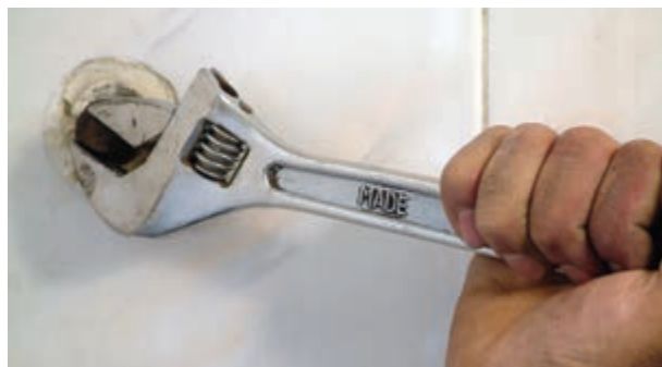
شکل ۱۸۲-۲- بازکردن درپوش‌ها
