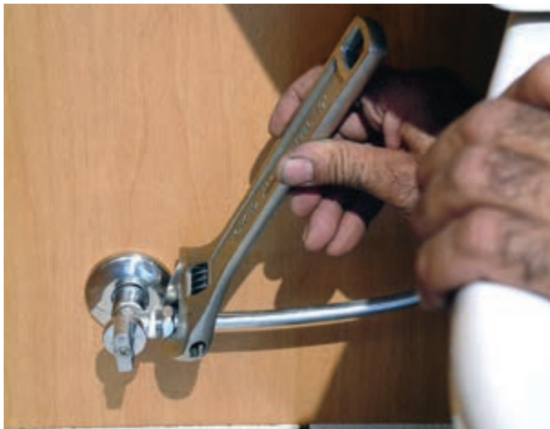
شکل ۳-۲۵۶- سفت کردن مهره‌ی شیر پیسوار
