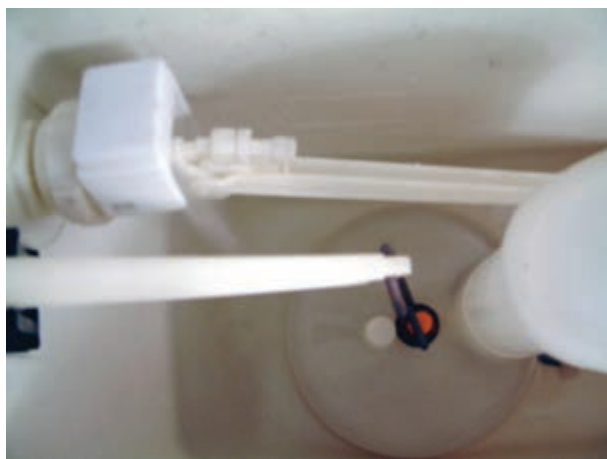
شکل ۲۲۴-۳- پر شدن مخزن فشاری
