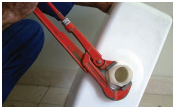
شکل ۳-۲۰۸- سفت کردن مهره‌ی پمپ تخلیه
