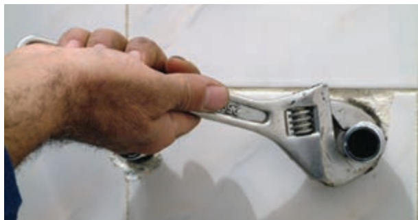
شکل ۲-۱۶۷- سفت کردن دنباله‌ها با آچارفرانسه
