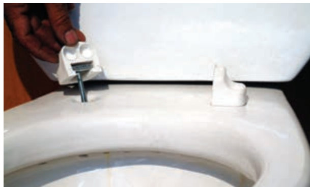
شکل ۳-۲۵۳- اتصال بست‌های نگهدارنده به توالت فرنگی
