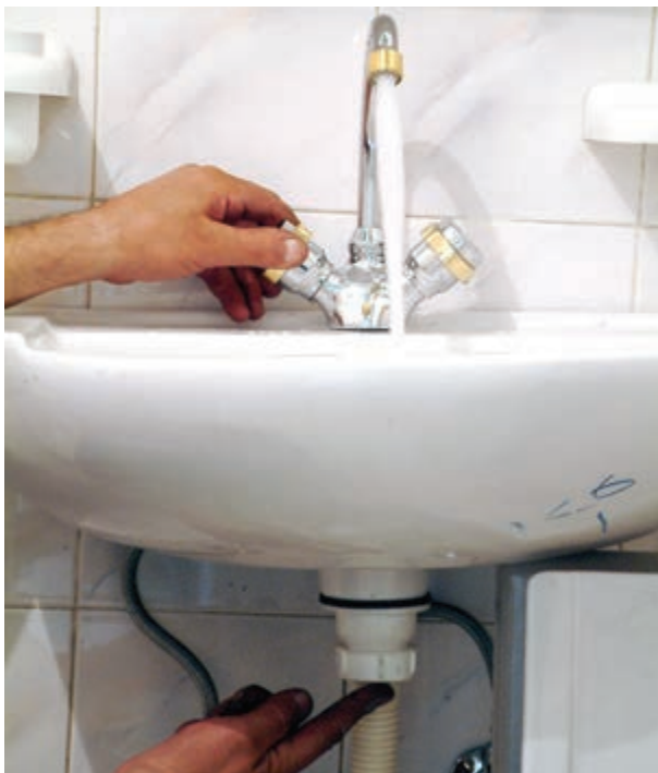
شکل ۳-۵۷ عمل کنترل نشت آب از محل‌های اتصال
