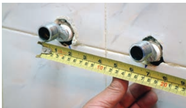
شکل ۲-۱۶۸- کنترل اندازه‌ی محور تا محور دنباله‌ها
