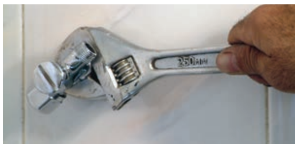
شکل ۳-۴۸ سفت کردن شیر پیسوار با آچار فرانسه
