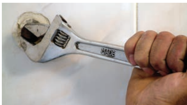
شکل ۱۴۱-۲ باز کردن درپوش
