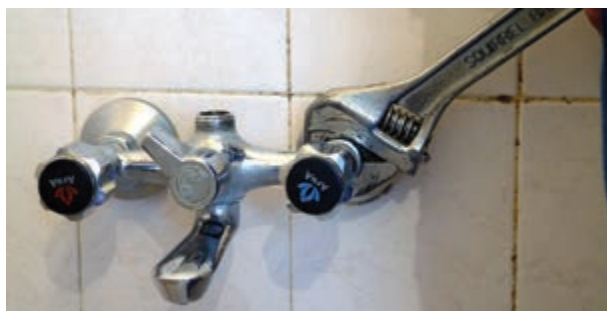
شکل ۲-۲۰۶- سفت کردن مهره‌های شیر با آچار
