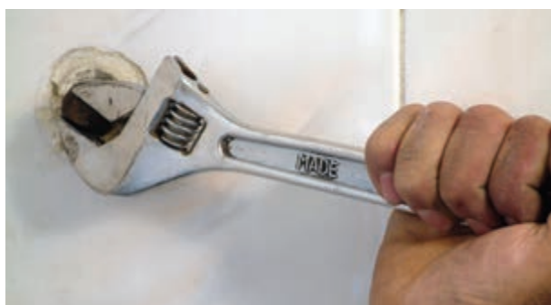
شکل ۱۹۸-۲- باز کردن درپوش‌ها
