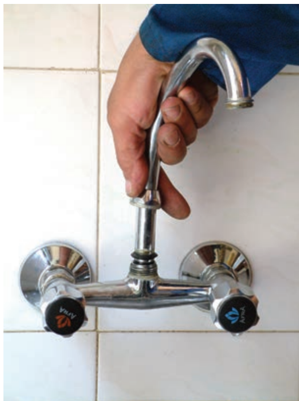
شکل ۲-۱۷۵- جازدن عَلم شیر مخلوط با دست در درون ناف شیر مخلوط
