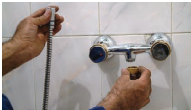
شکل ۲-۱۹۱- اتصال شیلنگ آفتابه به شیر مخلوط توالت
