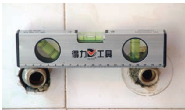
شکل ۲۰۳-۲- کنترل تراز بودن دنباله‌ها
