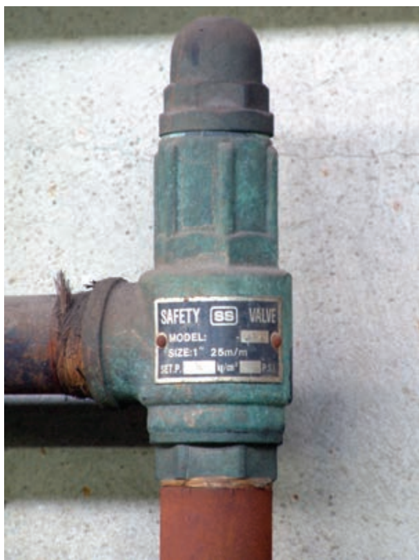
شکل ۲-۱۰۶ شیر اطمینان حساس در برابر فشار
