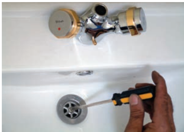
شکل ۳-۴۰ نصب زیراب بر روی دست شویی
