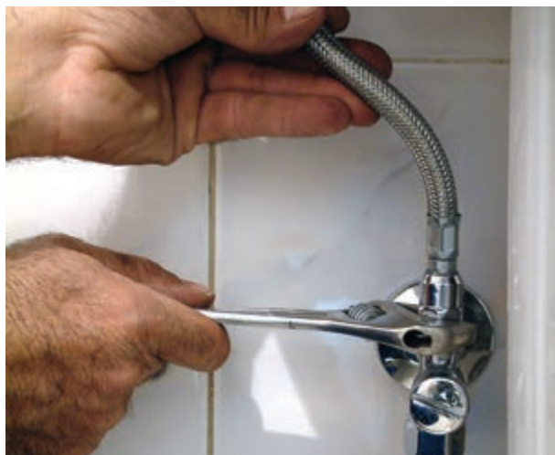
شکل ۳-۴۹ سفت کردن مهره‌های شیلنگ به شیر پیسوار
