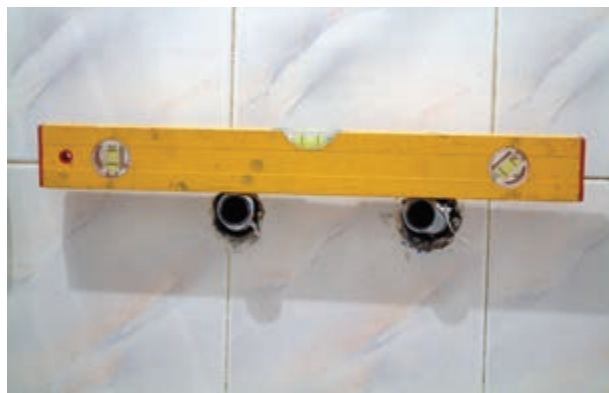
شکل ۲-۱۶۹- کنترل صاف بودن دنباله‌ها
