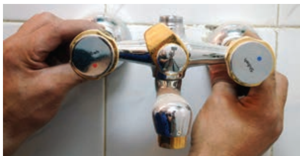
شکل ۲-۲۰۵- بستن مهره‌های شیر مخلوط دوش با دست
