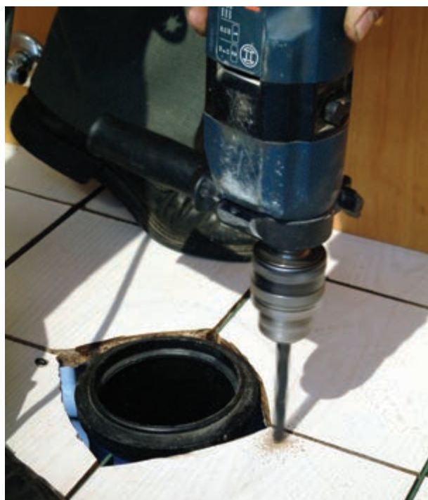
شکل ۲۴۶-۳- سوراخ‌کاری محل‌های علامت‌گذاری شده
