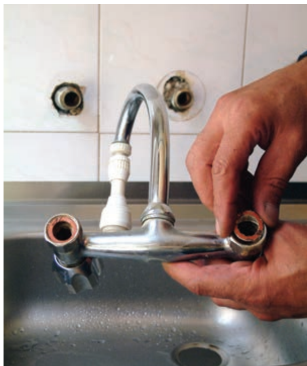
شکل ۲-۱۷۱- قراردادن واشر درون مهره‌ی تنه شیرمخلوط
