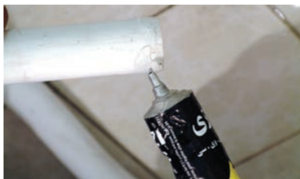
شکل ۳-۲۰۵- زدن چسب به لوله‌های تخلیه
