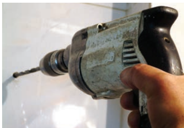
شکل ۲-۱۹۲- سوراخ کردن محل نصب بست آویز
