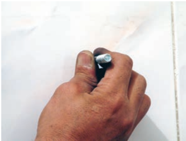
شکل ۳-۴۳- بستن پیچ‌ها در درون رولپلاک‌ها با دست
