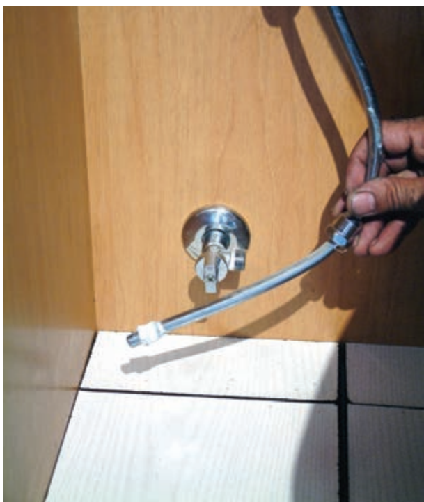
شکل ۳-۲۵۵- خمکاری لوله‌ی پیسوار
