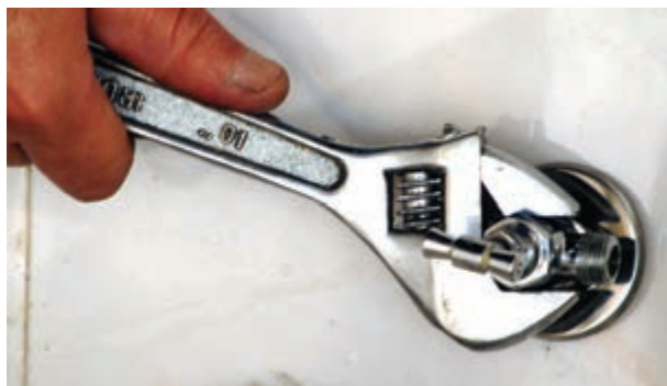
شکل ۱۴۴-۲- سفت کردن شیر پیسوار با آچار فرانسه
