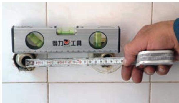
شکل ۲-۱۸۶- کنترل صاف بودن و اندازه‌ی دنباله‌ها
