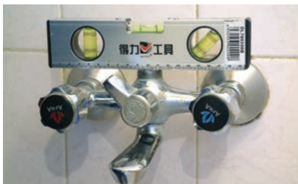
شکل ۲-۲۰۷- سنجش تراز بودن شیر مخلوط دوش
