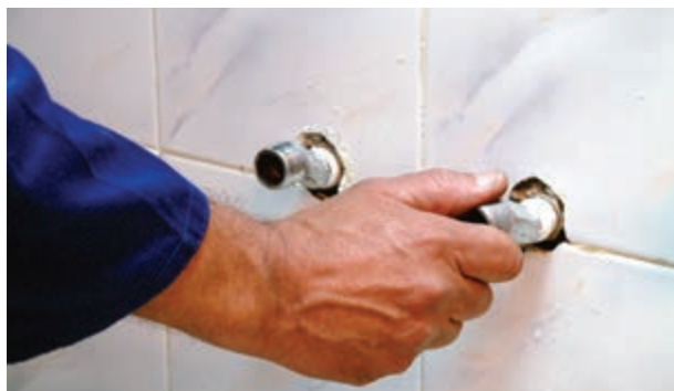
شکل ۲-۱۶۶- پیچیدن دنباله‌های شیر مخلوط دیواری با دست به لوله‌های آب سرد و آب گرم
