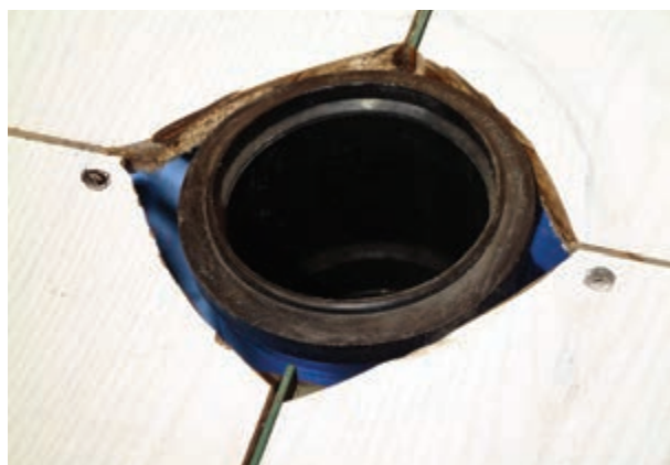
شکل ۲۴۴-۳- قراردادن بوگیر در داخل زانویی
