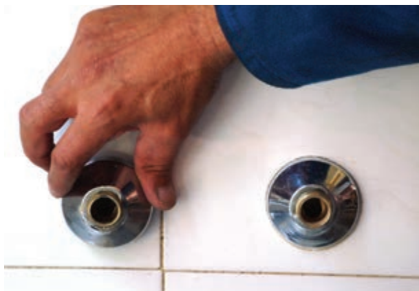
شکل ۲-۱۷۰- بستن کاسه‌ها به دنباله‌ها با دست
