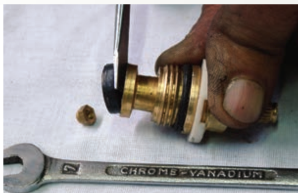
شکل ۲-۶۳- تعویض واشر
