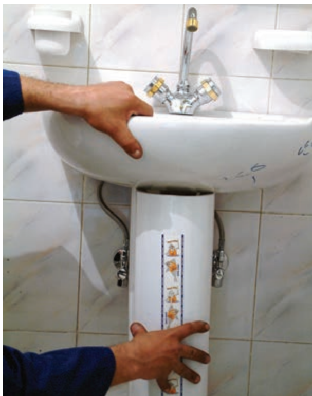
شکل ۳-۵۸- قرار دادن پایه‌ی دست‌شویی در زیر آن
