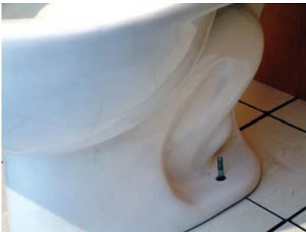
شکل ۲۴۸-۳- قرار دادن توالت فرنگی در محل خود
