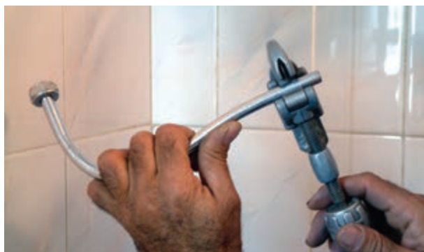
شکل ۲۲۲-۳- بریدن لوله‌ی پیسوار به وسیله‌ی لوله‌بر
