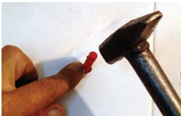
شکل ۱۹۳-۲- کوبیدن رولپلاک درون سوراخ
