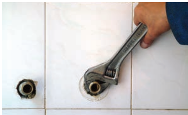
شکل ۲۰۱-۲- سفت کردن دنباله‌ها با آچار
