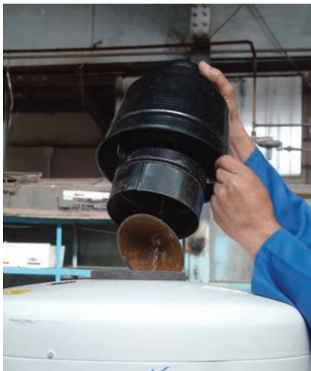
شکل ۱۱۵-۱ برداشتن کلاهک تعدیل از روی دودکش
