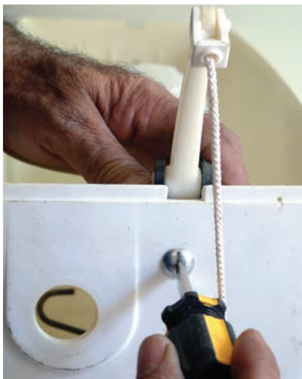
شکل ۳-۲۰۹- اتصال اهرم به بدنه‌ی مخزن فشاری
