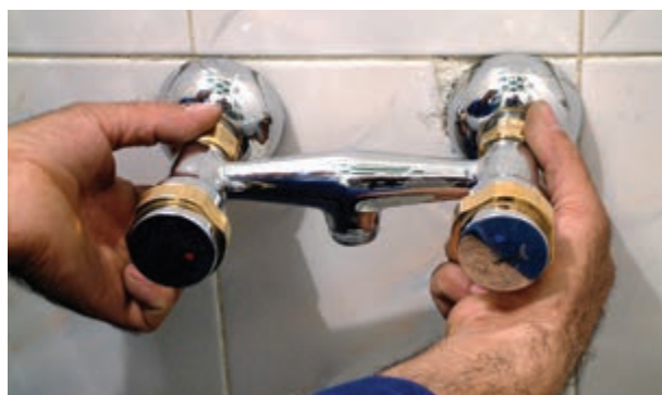
شکل ۲-۱۸۸- اتصال شیر مخلوط توالت به دنباله‌ها
