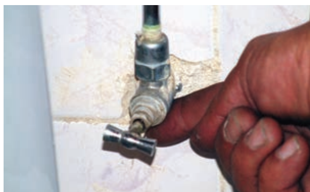
شکل ۱۴۷-۲- کنترل نشت آب از محل اتصال
