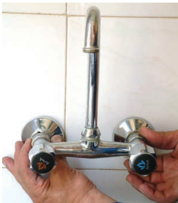
شکل ۱۷۲-۲ پیچیدن مهره‌ها به دنباله‌های شیر مخلوط
