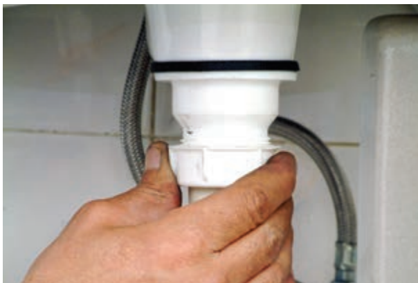
شکل ۳-۵۶ بستن مهره‌ی لوله‌ی عمودی سیفون به زیراب
