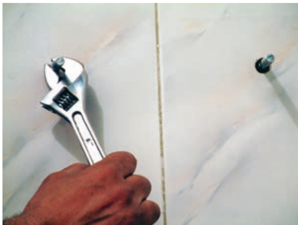
شکل ۳-۴۴- سفت کردن پیچ‌ها در درون رولپلاک‌ها
