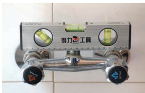
شکل ۱۷۴-۲ سنجش تراز بودن شیرمخلوط دیواری
