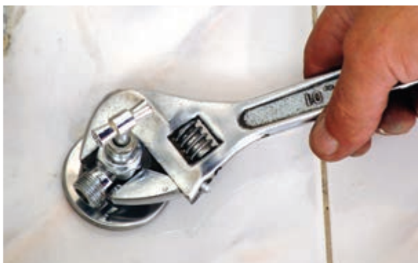
شکل ۲۲۰-۳- سفت کردن شیر پیسوار با آچار فرانسه
