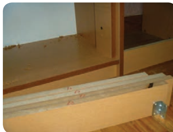
شکل ۱۶۶-۵- نصب پاسبنگ با استفاده از گونیای فلزی
