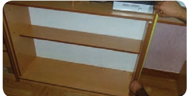
شکل ۱۷۳-۵- اندازه‌گیری برای نصب صفحه زیر کشوها
