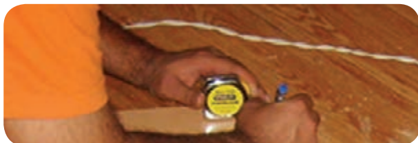
شکل ۵-۱۲۳- علامت‌گذاری و تعیین محل سوراخ‌ها
