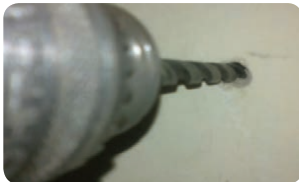
شکل ۶-۶ - سوراخکاری دیوار با مته الماسه مناسب
