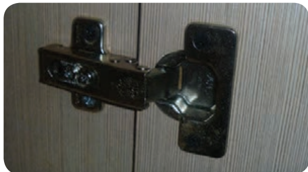
شکل ۵-۱۶۳- نصب لولای گازی فنردار به در کمد
