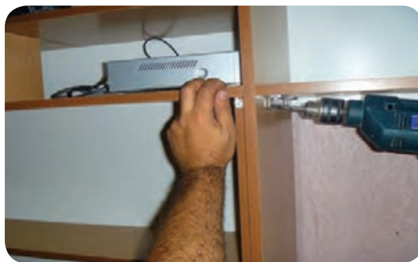
شکل ۵-۱۴۲- استفاده از اتصال گونیای فلزی در نصب طبقات
