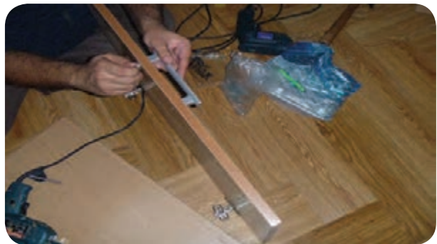
شکل ۱۵۹-۵- نصب دستگیره در کمد
