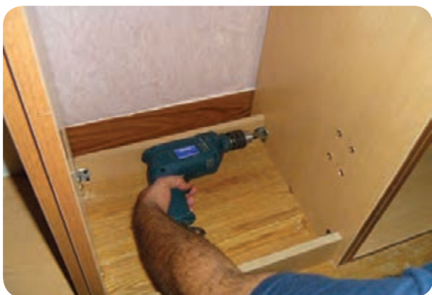
شکل ۱۸۰-۵- نصب پاسنگ‌ها
