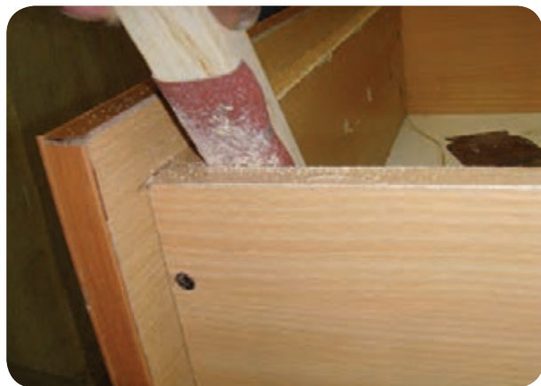
شکل ۵-۱۸۲- برطرف کردن لبهٔ تیز صفحات با سوهان
